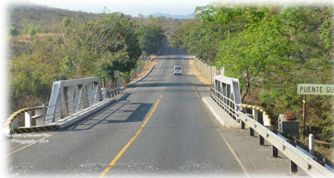
IMAGEN No. 5: ESTADO DE CARRETERA ACTUAL CA-9. FUENTE: http://www.pbase.com/m_escalante_herrera/image/102245665
