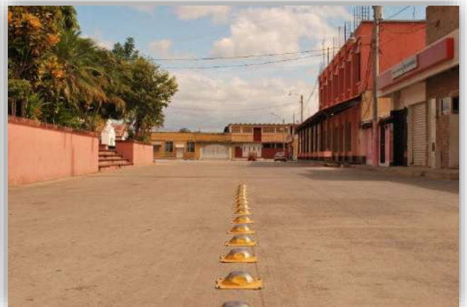
IMAGEN No. 31: CALLE DE LOS ALREDEDORES DEL PARQUE CENTRAL DEL MUNICIPIO DE RIO HONDO FUENTE: FOTOGRAFIA PROPIA.
