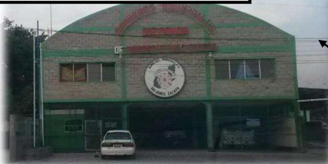
ESTACION DE BOMBEROS MUNICIPALES FUENTE: FOTOGRAFIA PROPIA.
