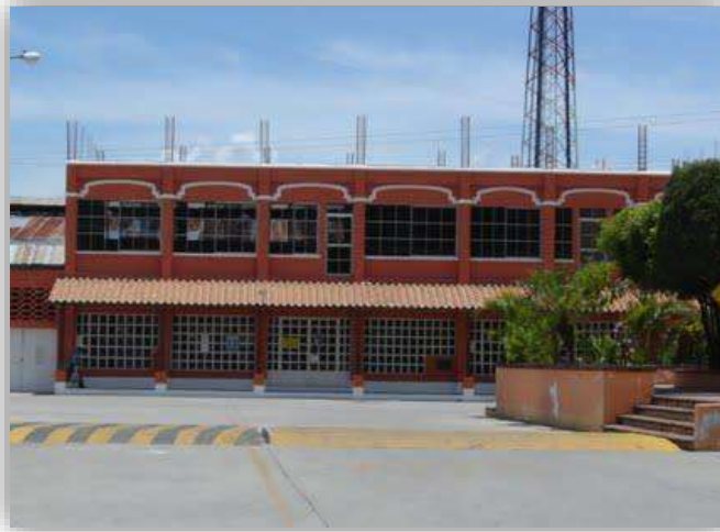
IMAGEN No. 20: EDIFICIO DE LA MUNICIPALIDAD DEL MUNICIPIO DE RIO HONDO FUENTE: FOTOGRAFIA PROPIA.
