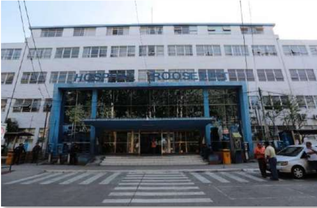
Figura 80. Hospital Roosevelt, Zona 11, Ciudad de Guatemala.
