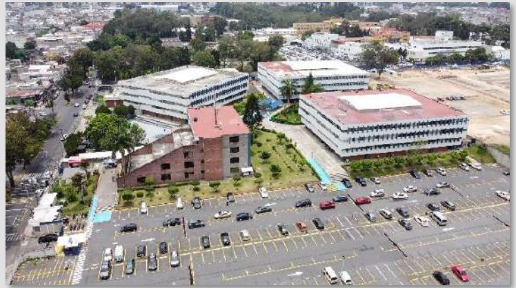
Figura 4. Sede del Centro Universitario Metropolitano – CUM, Universidad de San Carlos de Guatemala, zona 11, Ciudad de Guatemala
