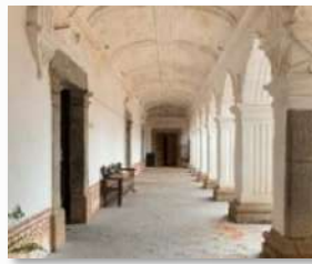
Figura 49. "Pasillo de Boveda, Antigua Sede USAC, La Antigua Guatemala".
