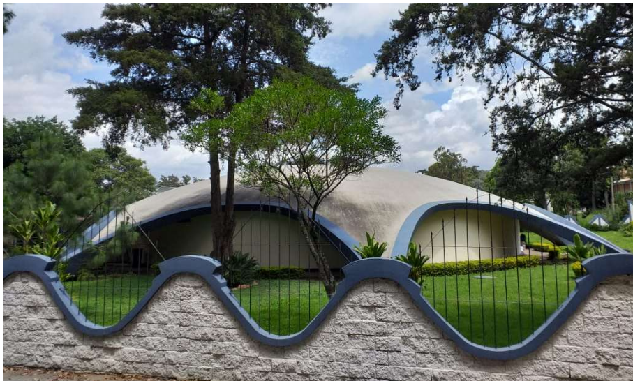
Fotografía 3. Edificio Aula Magna "Iglú". Su forma curva lo hace único dentro del Campus Universitario y demuestra todo lo que es posible expresar a través de la creatividad. El edificio mantiene los elementos estructurales de concreto y muros forrados de madera con acabados lisos.
