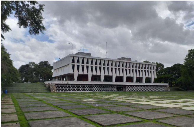
Fotografía 5. Edificio de Rectoría. Fachada posterior. Fuente: propia .
