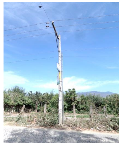
Fotografía 08: El terreno cuenta con tendido eléctrico, drenaje municipal y un pozo de agua potable.
