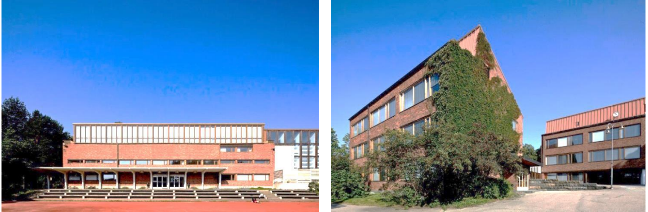
Figura 12 Vista frontal y perspectiva del edificio, integración de la vegetación al edificio.
