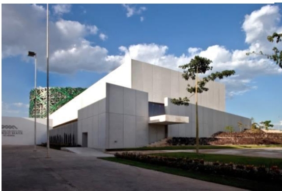
Figura 54 Vista sur, área de rampa peatonal.
