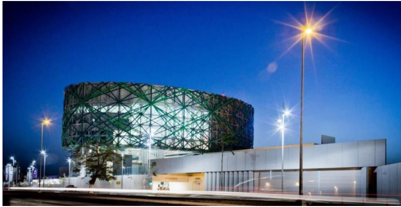
Figura 52 Vista noroeste, denota masividad en las fachadas principales.
