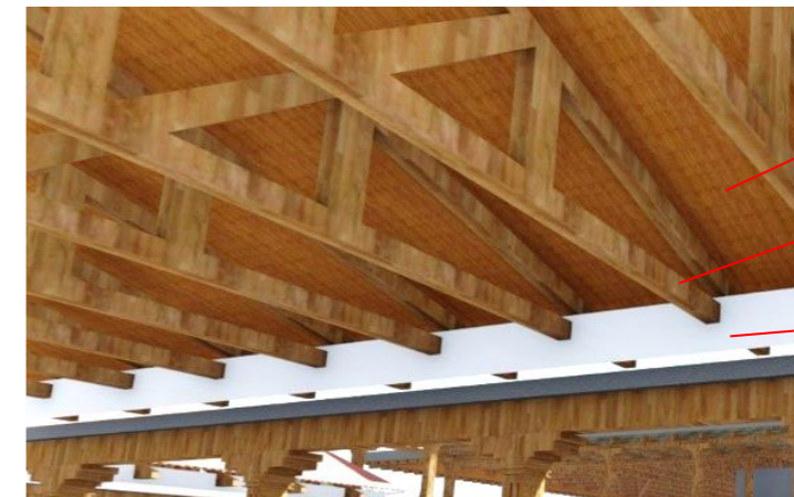
Vista interior del sistema de tijeras más la cubierta de madera
