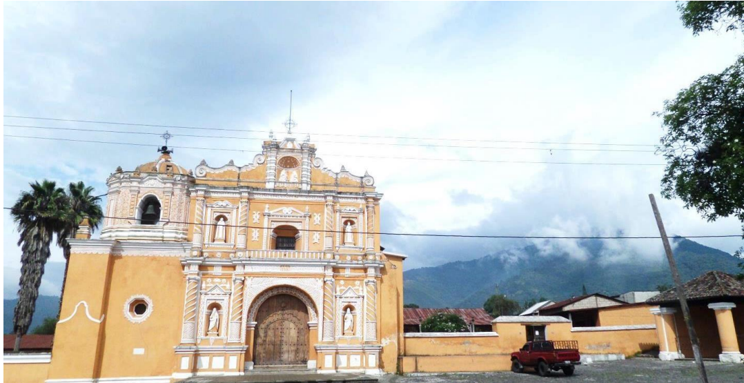
Figura 121 Fachada Iglesia Católica, aldea San Pedro Las Huertas, Antigua Guatemala, Sacatepéquez.
