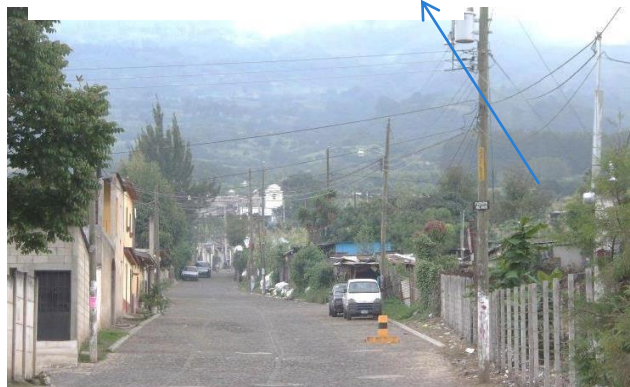
Figura 100 Calle empedrada que conduce a los cultivos de los pobladores.
