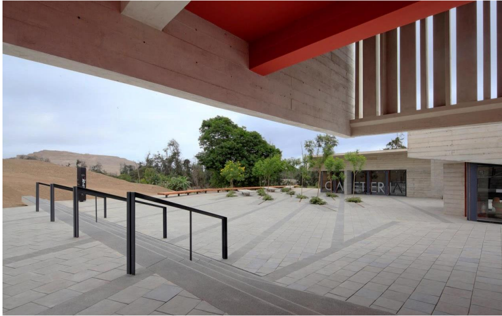
Figura 35 Voladizo y fachada.
