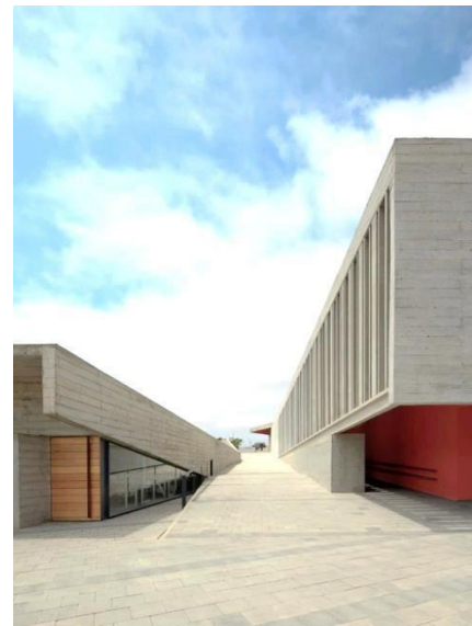
Figura 34 Se observan pasillos prolongados entre los edificios, lo cual da una sensación de horizontalidad al conjunto.
