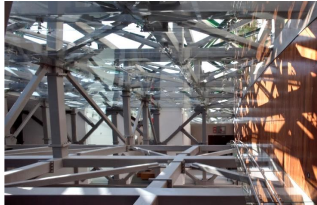
Figura 50 Vista interior, estructura.
