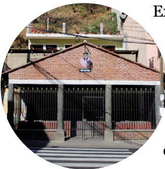
Figura 36: Pila comunal ubicada frente a la municipalidad. Fuente: propia.
