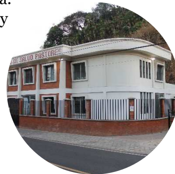
Figura 37: Centro de salud de Pastores. Fuente: propia.
