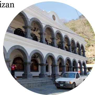
Figura 35: Edificio Municipalidad de Pastores. Fuente: propia.
