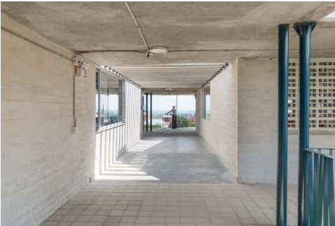
Figura 23: Pasillo interior. Fuente: https://www.relievearquitectura.com/parque-educativo
