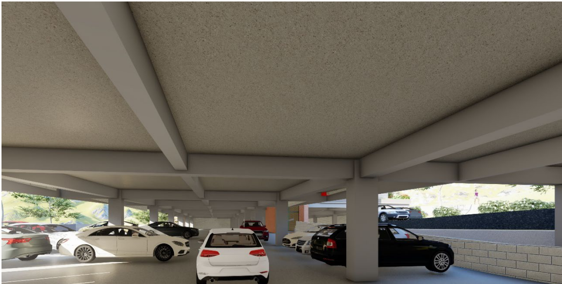
ZONA DE PARQUEO
