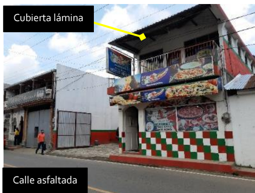
Figura 85. Construcciones hechas con block y cubierta de lámina. Fuente: fotografía propia, 2020. Tactic, Alta Verapaz.
