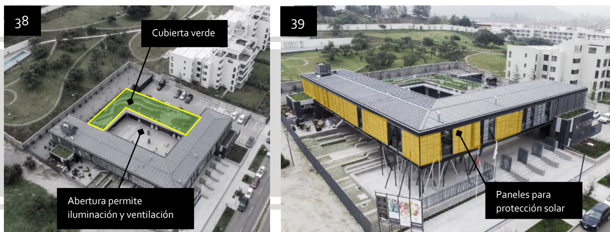
Figura 38 y 39. Vistas exteriores del Centro Cultural el Tranque.
