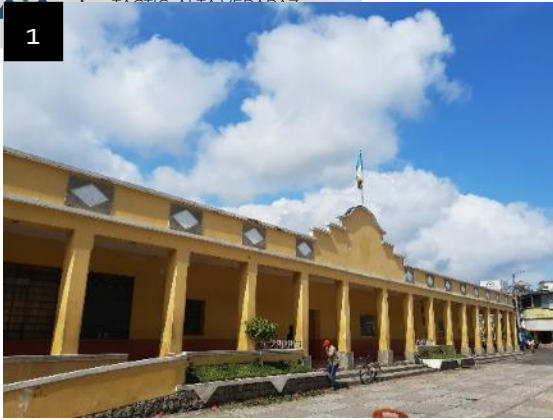
Figura 88. Edificio Municipal de Tactic, Alta Verapaz. Fuente: elaboración propia, 2020. Tactic, Alta Verapaz.
