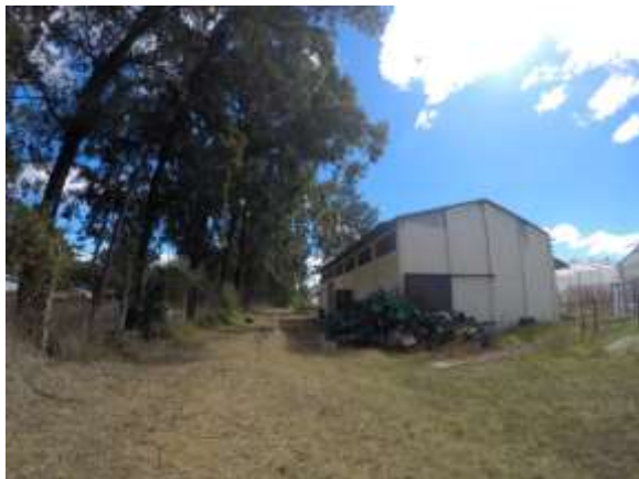
Figura 3.8i Bodega de carpintería
