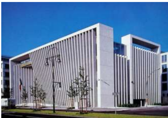
Figura 2.2.26 Uso de Parteluces en fachada del edificio de la Embajada México en Alemania.
