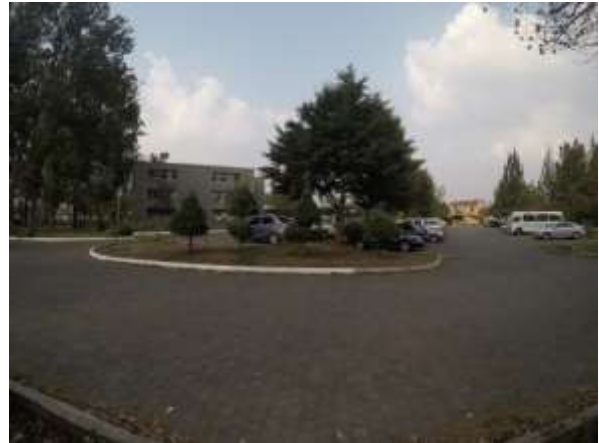
Figura 3.8b Edificio y parqueo UVIGER
