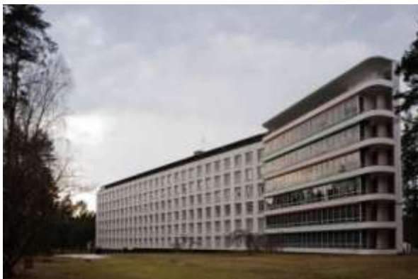
Figura 2.3.5 Vista exterior Sanatorio Piamo
