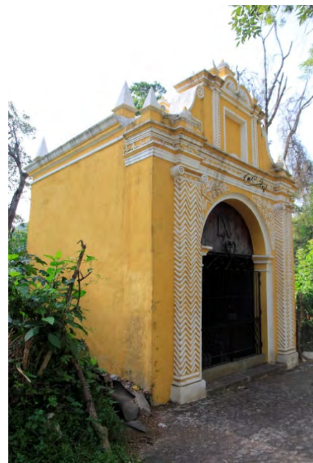
ILUSTRACIÓN 97 ERMITA QUE REPRESENTA LA ESTACIÓN IX. FOTOGRAFÍA POR ALVARO SALVATIERRA., JULIO 2018
