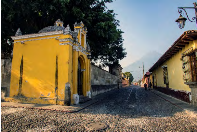
ILUSTRACIÓN 15 INICIO DE LA CALLE DE LOS PASOS EN DIRECCIÓN SUR. SE OBSERVA EN PRIMER PLANO LA ERMITA DEL PASO II. FOTOGRAFÍA POR ALVARO SALVATIERRA 2019
