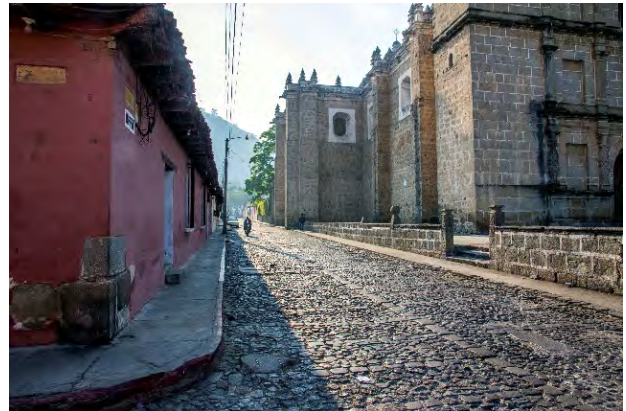
ILUSTRACIÓN 20 VISTA HACIA LA CALLE DE BELÉN. FOTOGRAFÍA POR ALVARO SALVATIERRA, ABRIL 2019
