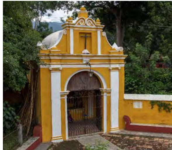
ILUSTRACIÓN 120 ERMITA XI, ESTADO ACTUAL, FOTOGRAFÍA POR ALVARO SALVATIERRA, OCTUBRE 2019
