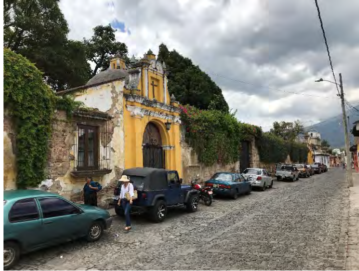
ILUSTRACIÓN 131 LA UTILIZACIÓN DEL LADO ORIENTE DE LA CALLE DE LOS PASOS COMO PARQUE DESVALORIZA EL RECORRIDO DE ALTO VALOR PATRIMONIAL. FOTOGRAFÍA POR ALVARO SALVATIERRA, JULIO 2019
