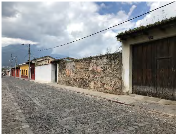
ILUSTRACIÓN 51 PERDIDA DE ACABADOS ORIGINALES SOBRE MURO. FOTOGRAFÍA POR ALVARO SALVATIERRA, JULIO 2019
