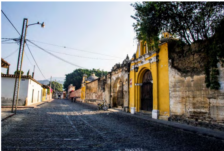
ILUSTRACIÓN 47 SISTEMA CONSTRUCTIVO SIGLO XVII. EXTREMOS SUPERIOR DERECHA, SE OBSERVA QUE EL MURO EN ESTA SECCIÓN ES DE ADOBE CON CIMENTACIÓN DE PIEDRA. FOTOGRAFÍA POR ALVARO SALVATIERRA, JULIO 2019
