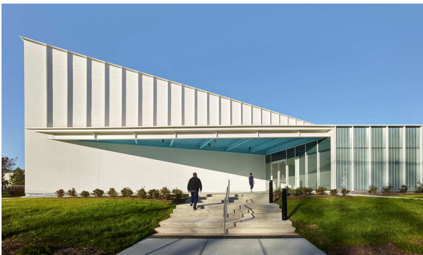
FIGURA 65. Ingreso principal del Centro de Capacitación, Recreación y Educación de Newark Fotografía en sitio web: https://www.plataformaarquitectura.cl/cl/931585/centro-de-capacitacion-recreacion-y-educacion-de-newark-iko-architects
