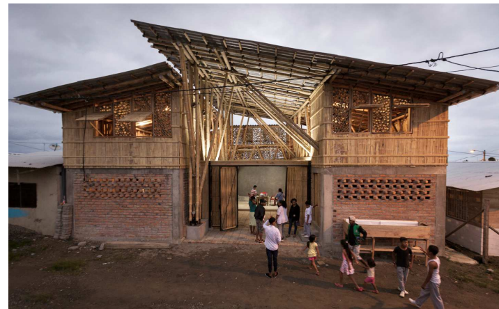
FIGURA 70. Centro Cultural Chamanga Fotografía. web: https://www.arquitecturapanamericana.com/centro-cultural-chamanga/
