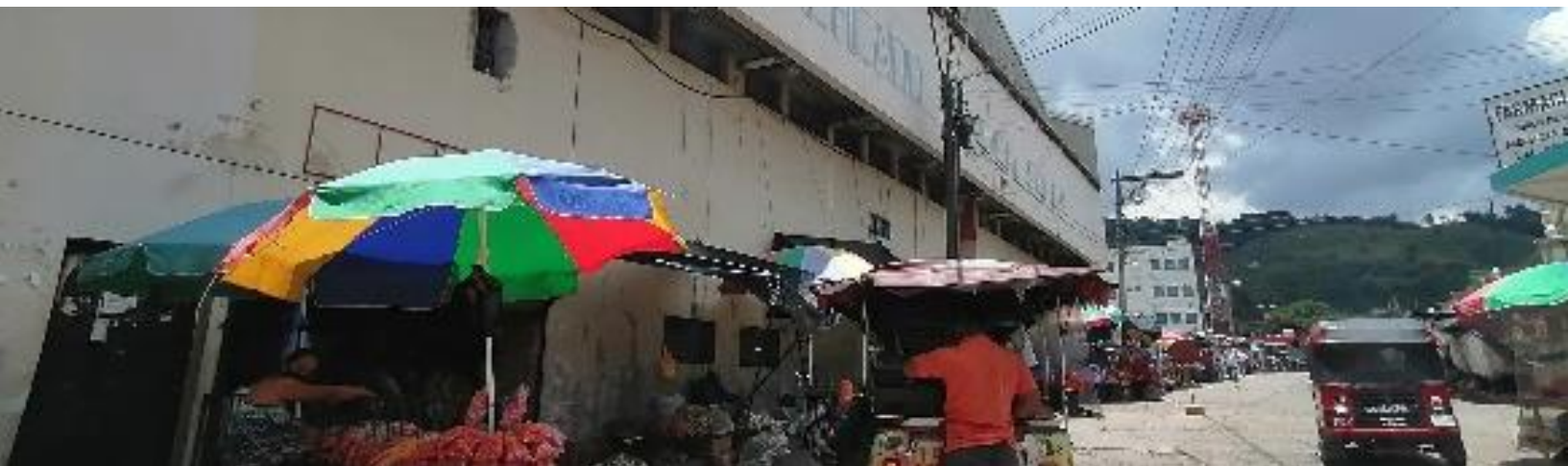
Ilustración 25 Fachada mercado municipal
