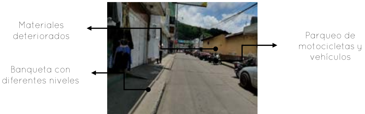
Ilustración 67 2da calle zona 1 área de parqueo
