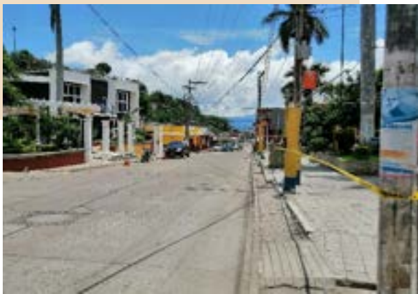
Ilustración 34 Estado de 1ra avenida enfrente de edificio municipal
