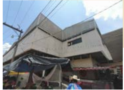
Ilustración 50 Fachada mercado municipal
