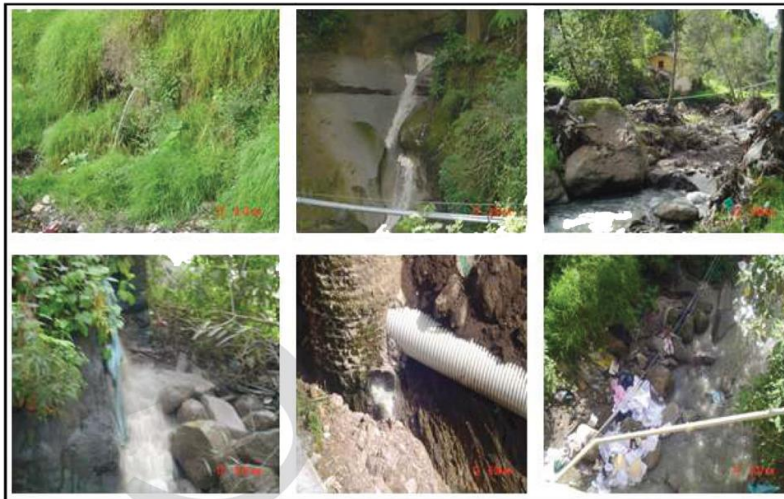
Figura No.11. Las fotografías nos muestran algunos lugares de los desfogues de las aguas residuales. Municipio de San Pedro Sacatepéquez, San Marcos. Fuente: MARN, delegación San Marcos 2010
