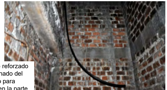
Ladrillo de barro cocido hiladas de 10 unidades de alto.
