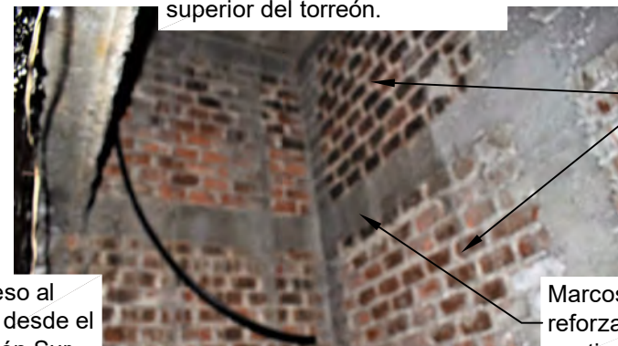
Marcos de concreto reforzado en voladizo escalonado del levantado de ladrillo para reducción de base en la parte superior del torreón.
