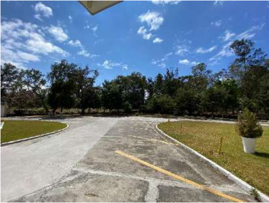
Figura 124. No.7 Vista hacia área seleccionada para biblioteca desde parqueo ITS. Fuente propia.
