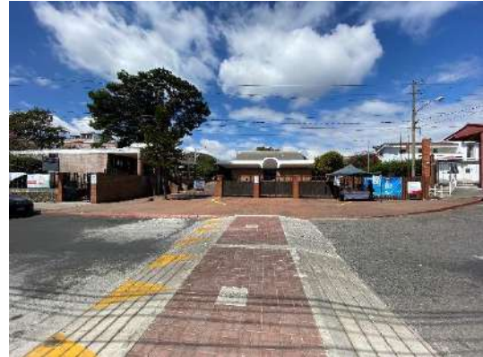
Figura 133. No.16 Vista desde 20 avenida hacia fachada principal de la Iglesia María Auxiliadora. Fuente propia.
