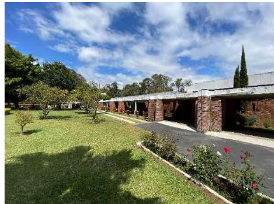
Figura 129. No.12 Vista externa hacia pasillo de acceso entre el módulo habitacional y edificio del ITS. Fuente propia.
