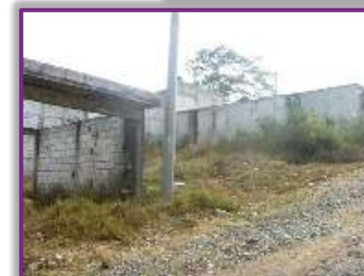
Vista de terreno A en dirección Oeste-Este. El terreno posee un grado de pendiente (ver zonificación de pendientes) y arbustos.
