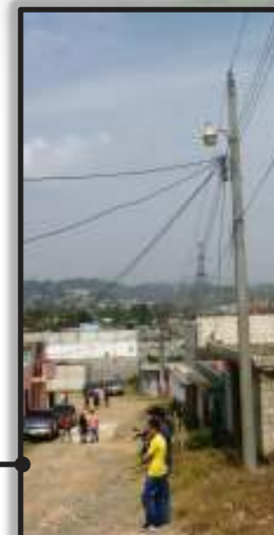
Vista 2da calle en dirección Este-Oeste. Resaltado el poste de electricidad donde actualmente se tiene conectada la acometida eléctrica de la Iglesia. No. De poste 501525
