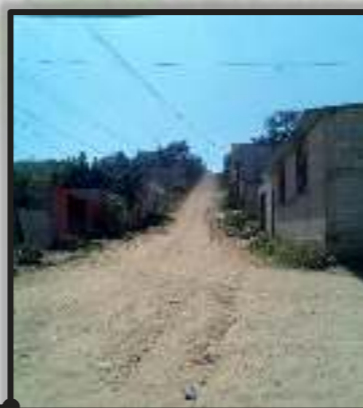
Vista de la 1ra calle, tiene un ancho de 6.60 metros promedio de acera a acera con un pendiente de 30% aproximadamente. En esta calle son muy pocas las casas que tiene acera. Esta calle al terminar la pendiente tiene tope.
