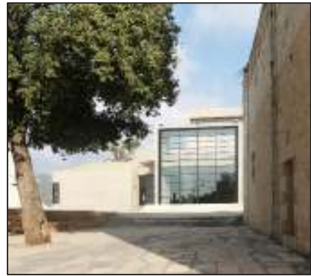
Figura No. 50 Fotografía desde Capilla Fuente: Karam Morcos, Majd Achi
