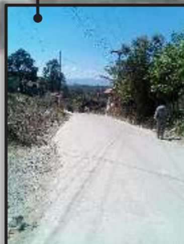
Vista de la avenida central (RD GUA-20) calle contigua a 3ra calle, es la única que esta pavimentada, tiene un ancho promedio de 6.60 metros de acera a acera de doble vía. Las aceras tienen un ancho de 1.20 metros. Esta calle conduce al sector 2 de Vistas de San Luis por bajo.
