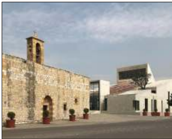
Figura No. 53 Fotografía desde Capilla Fuente: Karam Morcos, Majd Achi
