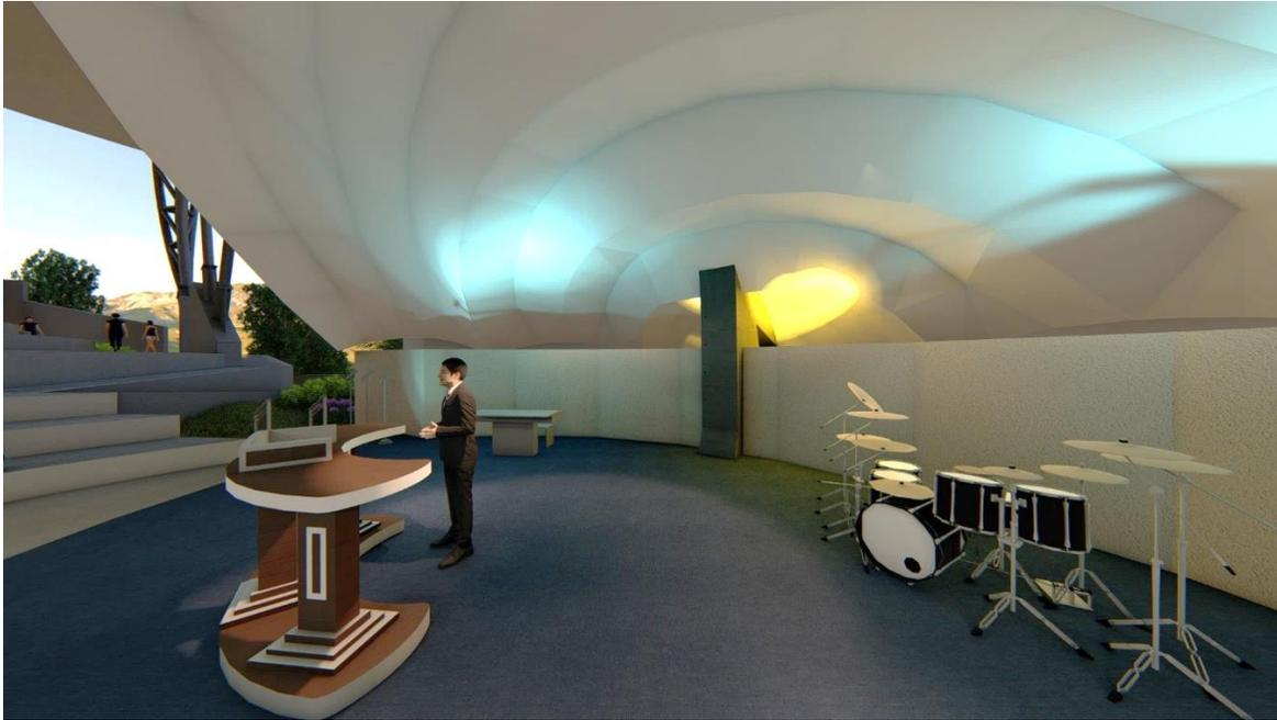
Vista arquitectónica del escenario que muestra la concha acústica. La estructura de la cubierta está elaborada por una tenso-estructura. Elemento principal es la estructura al centro que actúa como una columna/viga, de la cual sujetan por medio de cables los tensores de la cubierta. El material de cubierta se compone de varillas de acero de alma vacía con forma de arco para sostener la forma de la lona. Fuente: elaboración propia.
