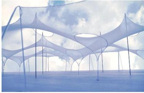
*Fig. #3. Esquema de una tenso-estructura utilizada en el pabellón Alemán en la exposición universal de 1967. Muestra los puntos de apoyo y la forma lograda por medio de la fibra de poliéster. Fuente: <https://www.plataformaarquitectura.cl/cl/768540/clasicos-de-arquitectura-pabellon-aleman-expo-67-frei-otto-rolf-gutbrod>.*
