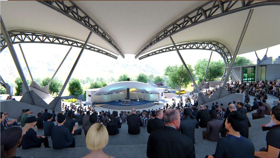
Vista arquitectónica desde nivel superior de graderío, con vista hacia el escenario. Se muestra la estructura de cubierta elaborada con una tenso-estructura. Apoyos de estructura en 3 puntos con la estructura principal actuando como una columna/viga para lograr una mayor estabilidad. Fuente: elaboración propia.
