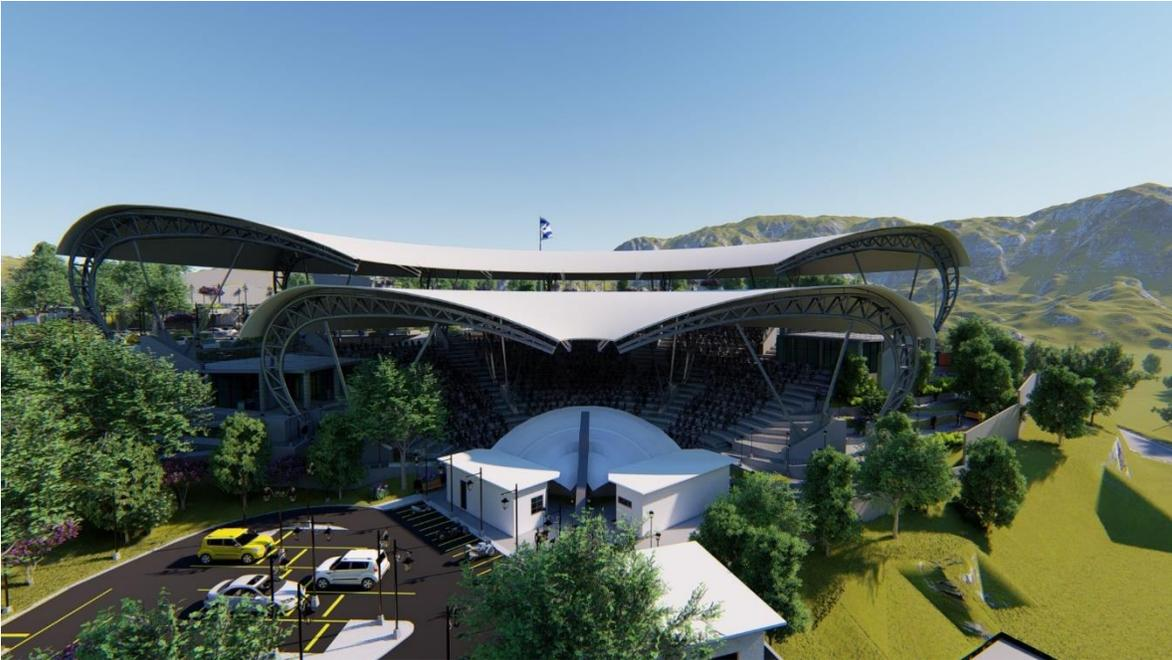
Vista arquitectónica frontal de la tenso estructura de la cubierta del graderío. (prolongación de la cubierta para mejorar la mitigación de la incidencia solar directa y precipitación de lluvia). Fuente: elaboración propia.
