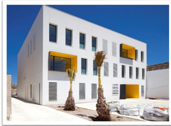
Fotografía 7 Centro de salud Porreres, España
