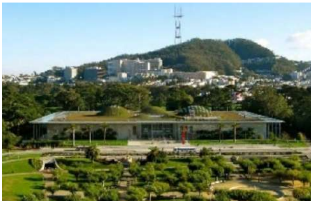
Figura 16: Academia de Ciencias de California. Fuente: Academia de Ciencias de California. Plataforma Arquitectura. 2019. https://www.plataformaarquitectura.cl/cl/923486/academia-de-ciencias-de-california-renzo-pianobuilding-workshop-plus-stantec-architecture-2
