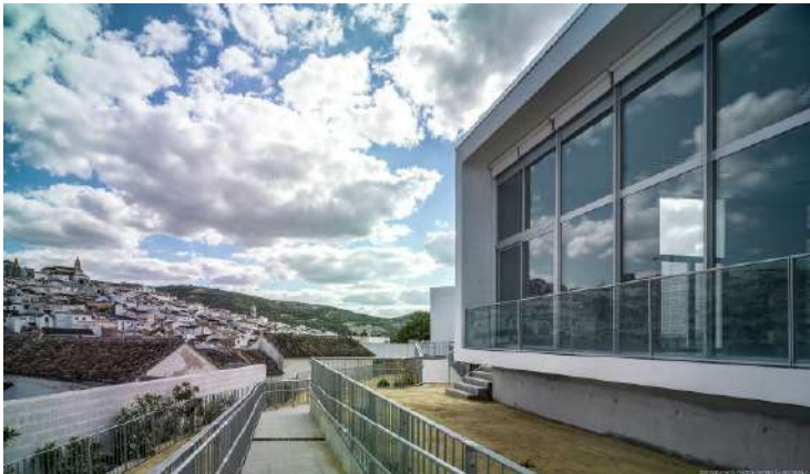
Figura 33: Fotografía de los ventanales del Centro de atención para la tercera edad. Fuente: «Centro de atención para la tercera edad». Jesús Granada, 2015.
