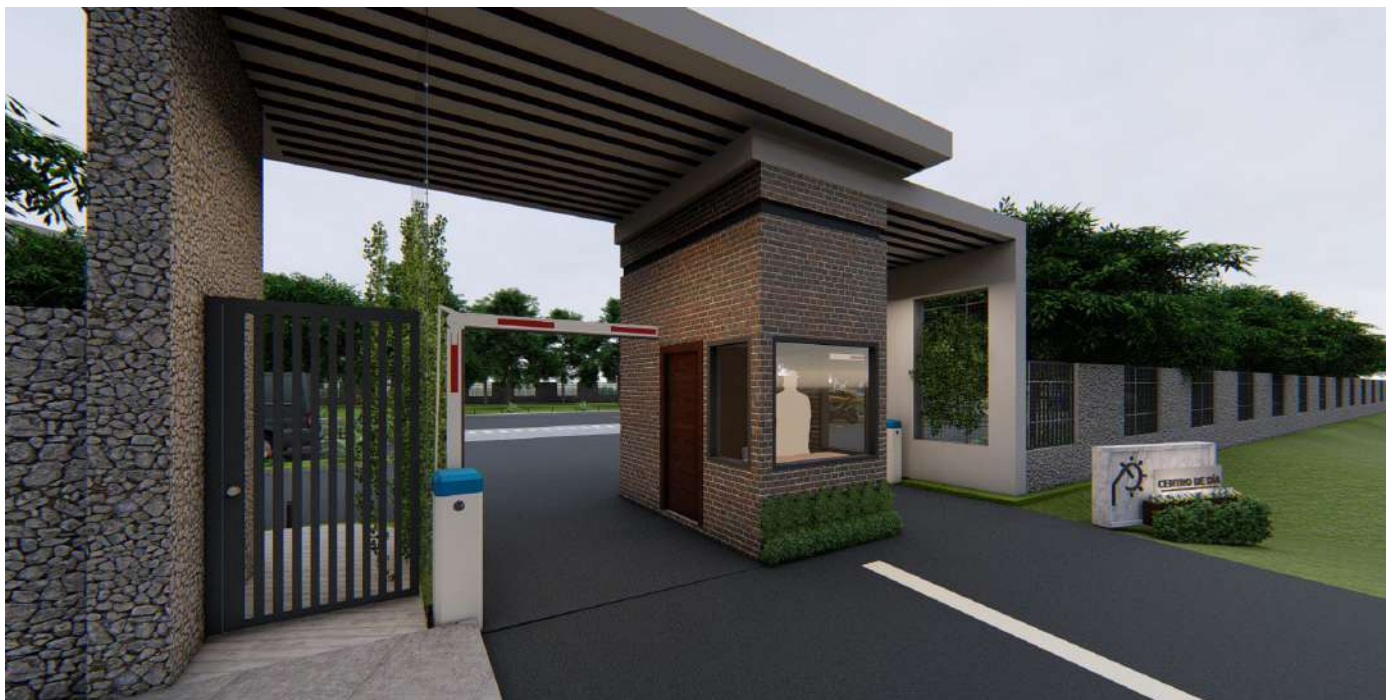
GARITA DE INGRESO
