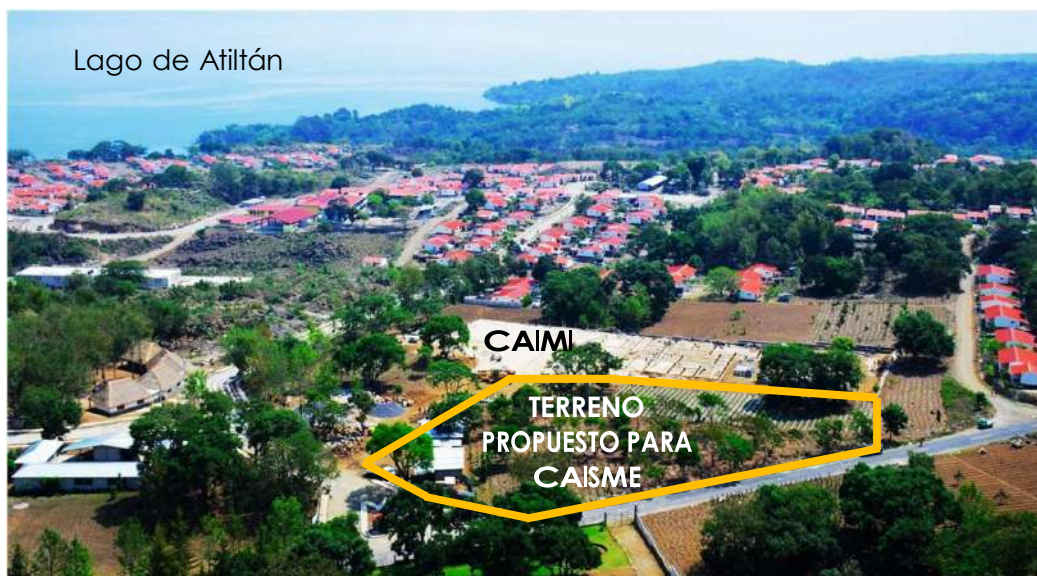
Figura 44: Vista aérea de nueva aldea Chuk Muk, instalaciones de CAIMI y terreno CAISME
