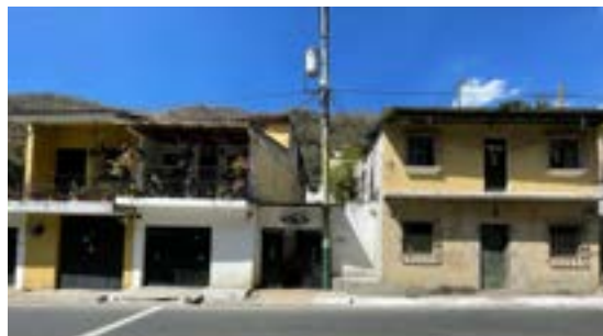
Figura 41. Poste eléctrico con transformador Fuente: Elaboración propia
