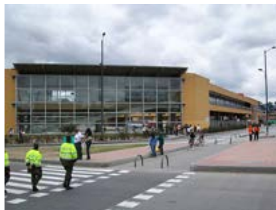
Figura 17. Fachada posterior Terminal del Sur, Bogotá Fuente: https://www.terminaldetransporte.gov.co/ .
