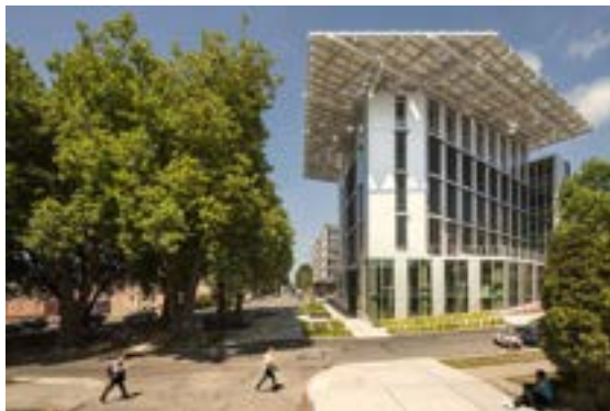
Figura 7. Bullitt Center ejemplo de Arquitectura Sostenible a escala media
