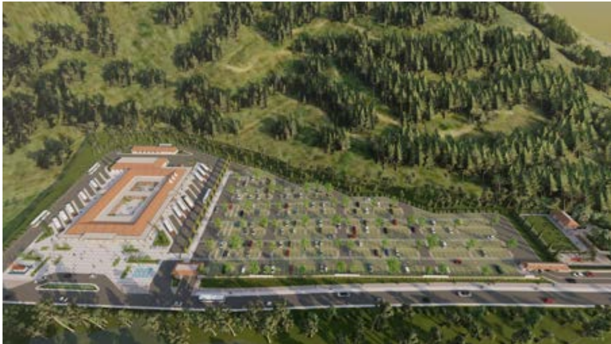
Figura 97. Vista aérea conjunto Fuente: Elaboración propia
