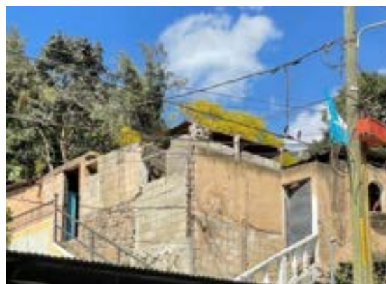
Figura 37. Casas de block visto o con repello faltante, posterior a ellas vegetación proveniente de la montaña Fuente: Elaboración propia
