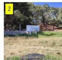
POZO DE AGUA
