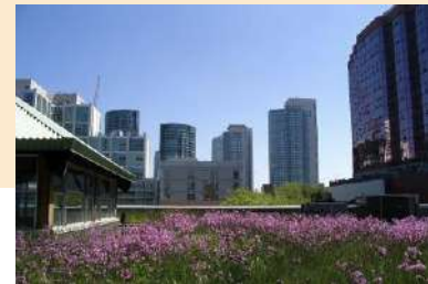
FIGURA 22. Cubierta verde en la empresa Mountain Equipment Coop en Toronto. Fuente: https://www.cupastone.es/5-paises-lideran-arquitectura-sostenible/
