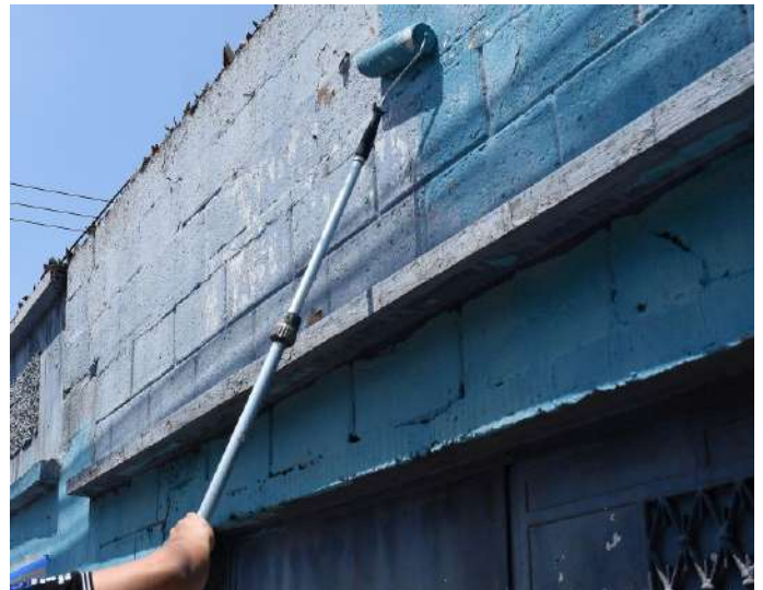
Figura 73. Revitalización fachadas 5ta. Avenida Villa Nueva Fuente: Municipalidad de Villa Nueva
