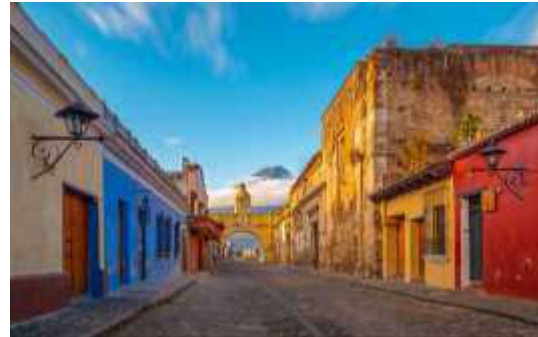
Imagen 10 - Arco de Santa Catalina, ubicada en 5a Avenida, Antigua Guatemala, renovada en 2017. Descripción: Se observa una paleta colores aplicada a las fachadas de las viviendas para mejorar la imagen urbana de la ciudad. Fuente: https://www.freejpg.com.ar/imagenes/premium/113714-6624/paisaje-urbano-de-antigua-city-guatemala/ , consultado en diciembre de 2021.
