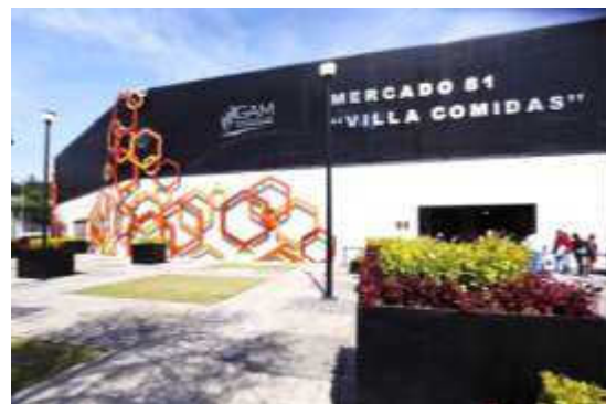
Imagen 12 - Mercado 81 "Villa Comidas", ubicado en la ciudad de México (2017). Descripción: Construcción de un nuevo mercado de 2,350 m 2 , de concreto armado, estructuras metálicas y techocurvo con iluminación, ventilación natural y elementos urbanos. Fuente: https://twitter.com/ManceraMiguelMX/status/944283995528945666/photo/3 . consultado en diciembre de 2021.
