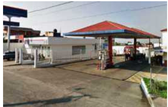
Imagen 45 - Gasolinera B & W ubicada ubicada en la Calzada Henry Sierra.
