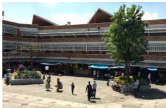
Imagen 17 - Fachada Este, Mercado San Juan de Dios. Descripción: Patio central, ingreso lado este hacia el mercado. Fuente: https://www.timeoutmexico.mx/ciudad-demexico/shopping/mercado-libertad-mercado-de-san-juan-de-dios , consultado en julio de 2022.
