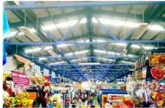
Imagen 16 -Estructura en el interior del mercado Concepción. Descripción: Se observa en color azul, la estructura “joist” tipo tijera, la cual soporta la carga de la cubierta. Fuente: Fotografía propia 2019.
