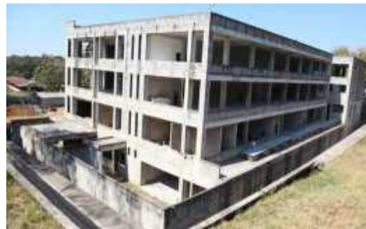
Imagen 35 - Comisaria Distrital de la PNC de Coatepeque. Descripción: En la fotografía se observa que la edificación esta en fase de construcción y contará con 4 niveles de construcción. Fuente: http://mingob.gob.gt/48385-2/
