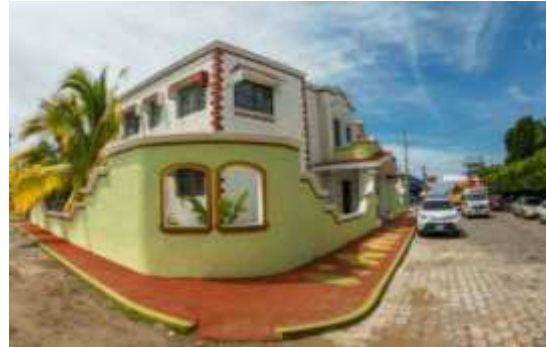
Imagen 32 - Biblioteca municipal, Gilberto Mathamba Alvarado ubicada en la zona 3 del Barrio San Francisco, Coatepeque. Descripción: Se observa la remoción del exterior de la biblioteca municipal, realizada por la corporación municipal Alfonso García Junco Hemmerling realizada en el año 2020. Fuente: Fotografía Corporación tikons año 2020.
