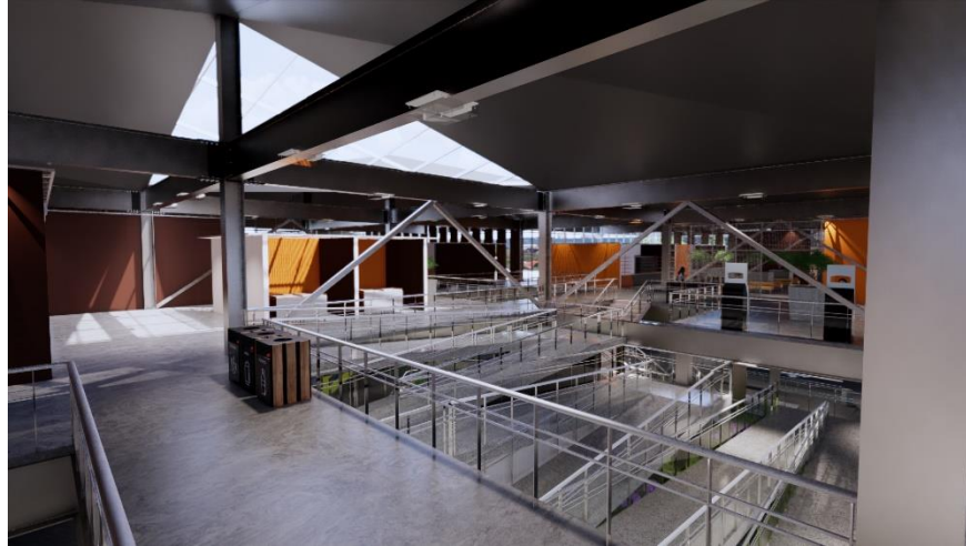
Figura 136. Elaboración propia. Imagen interior donde se observan los marcos rígidos de acero.
