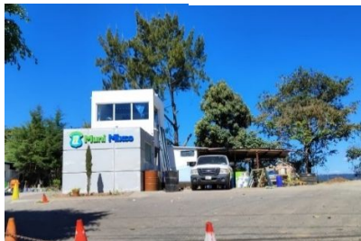
Imagen 48. Subestación de bomberos, zona 11 de Mixco
