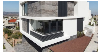
Imagen 9. Tendencias arquitectónicas Fuente: Grupo Volta
