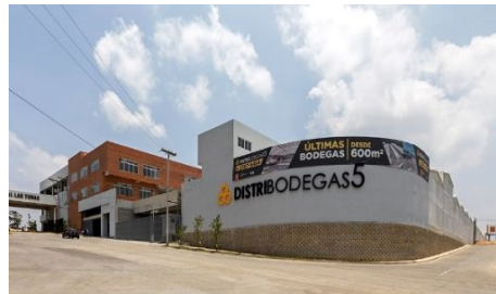
Imagen 28. Parque Industrial Las Tunas - zona 4 de Mixco Fuente: Qualicons
