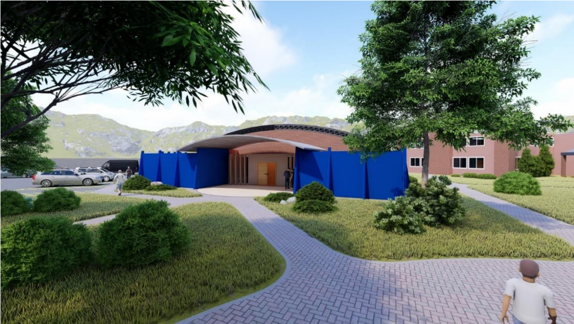
INGRESO A SALÓN DE USOS MÚLTIPLES.
