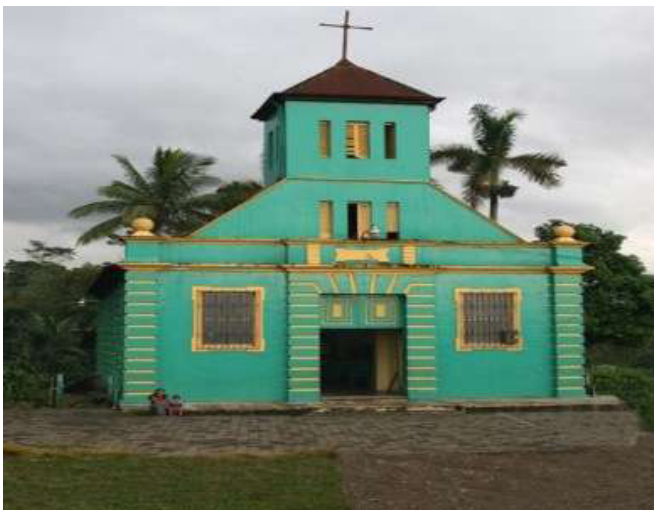
FIGURA 16: Iglesia de Chocolá en la Ruta a la Cabecera: https://www.pbase.com/image/118003268
