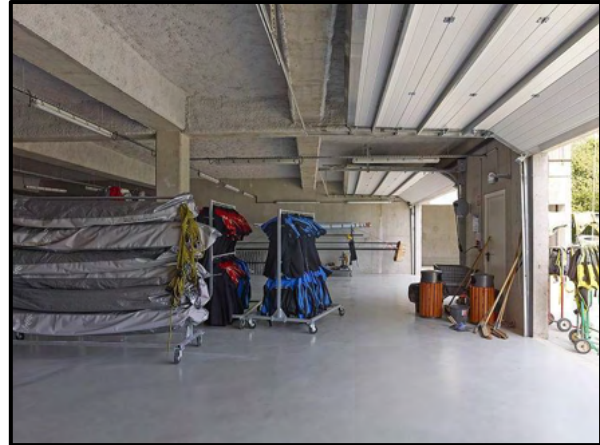
Figura 87 – Pineau, N. Chalmeau, S. (2014). Estructura de vigas y columnas de concreto del nivel inferior. [Fotografía]. https://www.archdaily.co/co/766727/centro-de-ocio-lac-de-vioreau-guinee-et-potin-architects?ad_medium=gallery
