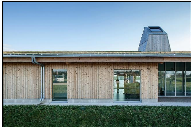
Figura 86 – Pineau, N. Chalmeau, S. (2014). Fachada de madera del Centro de ocio. [Fotografía]. https://www.archdaily.co/co/766727/centro-de-ocio-lac-de-vioreau-guinee-et-potin-architects?ad_medium=gallery
