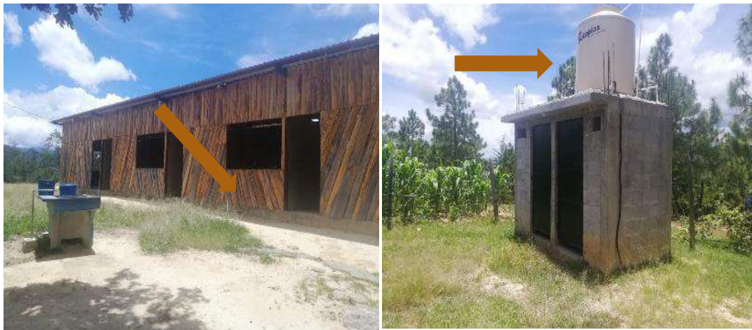
Figura 58. Tanques de almacenamiento de agua potable existentes en el terreno. Fuente: Fotografías propias
