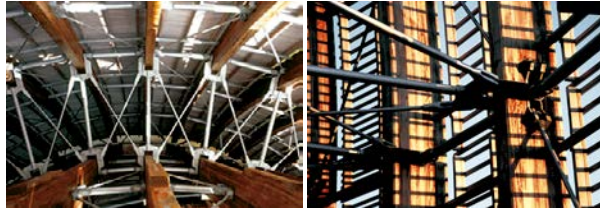
FIGURA NO. 59: Detalle de la estructura interior de cada uno de los módulos de madera y su interconexión entre sus elementos. Fotografía de sitio web: https://arquitecturaviva.com/obras/centro-cultural-jean-marie-tjibaou-noumea
