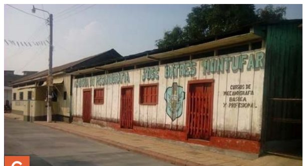
6 Colegio con estructura de madera y lámina metálica
