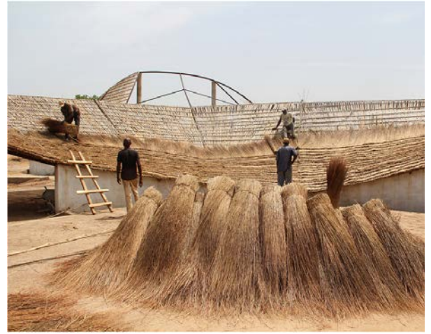
FIGURA NO. 86: Sistema constructivo basado en paja con el fin de ser consciente del medio ambiente y como un método pasivo de confort climático. Foto de sitio web: https://es.wikiarquitectura.com/edificio/centro-cultural-thread/#
