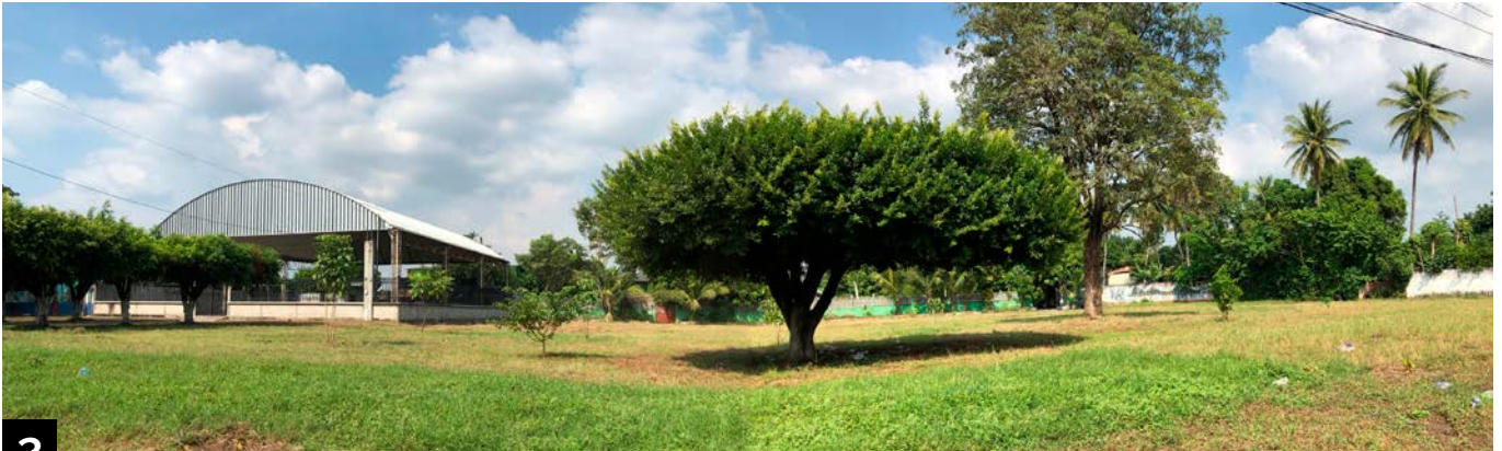
2 Vista panorámica del terreno desde su frente sur
