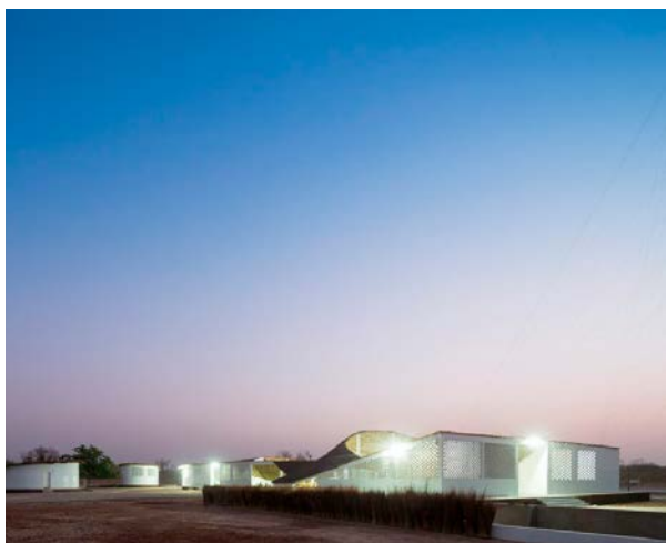
FIGURA NO. 77: Vista nocturna del centro cultural. Foto de sitio web: https://arquitecturayempresa.es/noticia/centro-cultural-y-residencia-de-artistas-thread-senegal-toshiko-mori-architects
