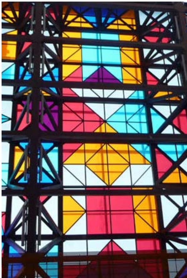
FIGURA NO. 70: Detalle de vitrales situados en la cubierta sobre la estructura triangulada metálica del centro cultural. Fotografía de sitio web: https://www.plataformaarquitectura.cl/cl/02-52707/centro-cultural-gabriela-mistral-cristian-fernandez-arquitectos-lateral-arquitectura-diseno
