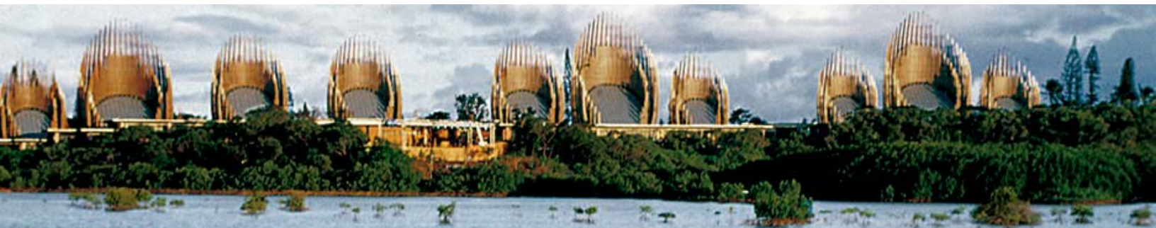
FIGURA NO. 48: Vista en elevación posterior del Centro Cultural Tjibaou. Fotografía de sitio web: https://es.wikiarquitectura.com/edificio/centro-cultural-jean-marie-tjibaou/#
