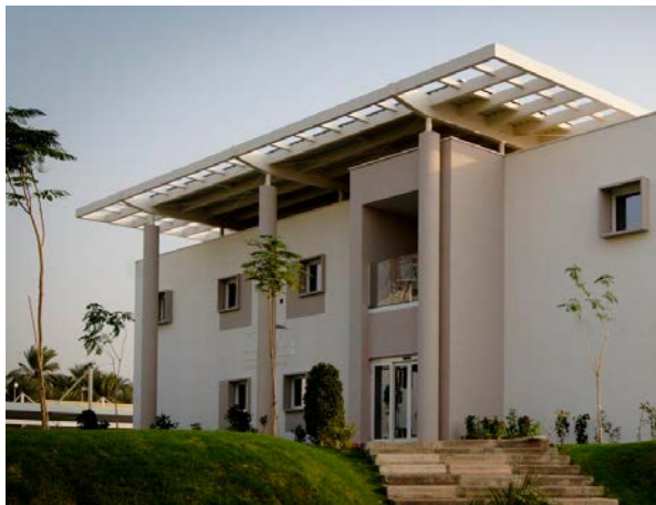
FIGURA NO. 6: Centro Espacial Mohammed bin Rashid, Yousuf Hamad (Dubai). Fotografía en sitio web: https://www.construction21.org/france/articles/h/20-synthese-etudes-de-cas-climats-chauds.html
