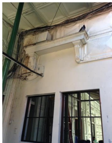
Figura 95. Sustitución de paneles metálicos por pared de sistema mixto e instalación de ventanas de materiales, dimensiones y ubicación diferentes a la original. Fuente: Elaboración propia. Año 2013.
