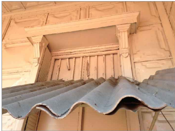
9. Colocación de aleros a media altura de puertas
