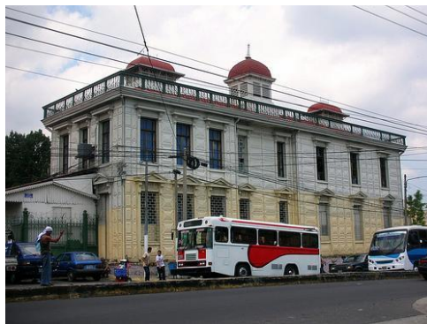
Figura 74. Paradas de buses y ventas ambulantes al exterior del hospital Fuente: http://wikimapia.org/3130993/es/Hospital-Nacional-Rosales
