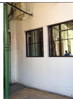
Pared Norte de sistema mixto en sustitución de lámina troquelada original, ventanas aluminio/vidrio.
