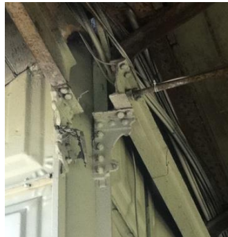
Figura 55. Techo de los pasillos apoyado en estructura emperrada, adosada a paredes de pabellones. Fuente: Elaboración propia. Año 2013.
