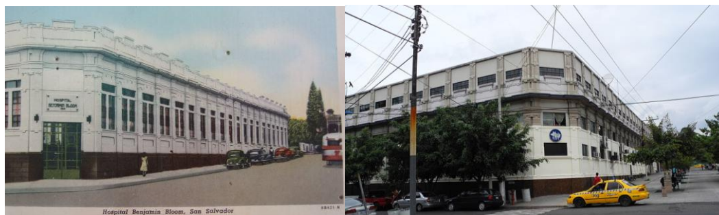
Figuras 16 y 17: Izquierda: Antiguo Hospital Bloom inaugurado en 1928. Derecha: El mismo edificio, remodelado, con un piso más, actualmente ocupado por el Hospital 1º de mayo del ISSS. Fuente: La Calle Arce y su diseño francés.
