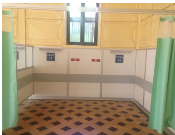
Figura 90. Instalación de pared falsa de madera comprimida en la cabecera de camas. Fuente: Elaboración propia. Año 2015.
