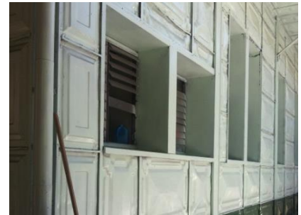
Figura 88. Desmontaje y recorte de paneles metálicos para abrir nuevas ventanas con marco de concreto. Fuente: Elaboración propia. Año 2013.
