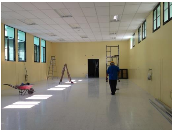
Figura 89. Sustitución de material de piso, ventanas, cielo falso y rostro interno de paredes. Fuente: Elaboración propia. Año 2015.
