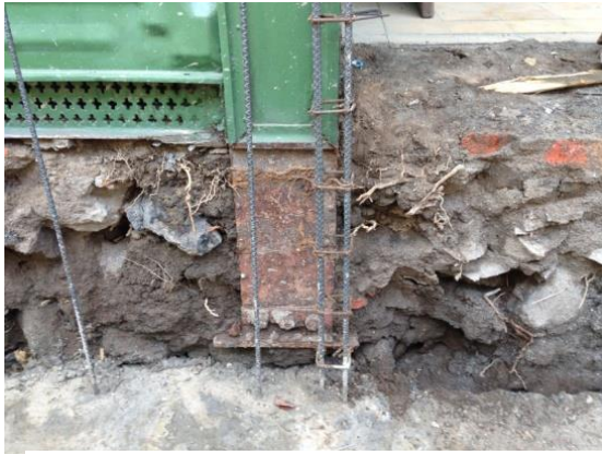
Figuras 52 y 53. Los cimientos de los edificios son de mampostería en unos casos de piedra y en otros de ladrillo de barro, en las cuales se encuentran empotradas o apoyadas las columnas de metal. Elaboración propia. Año 2015.
