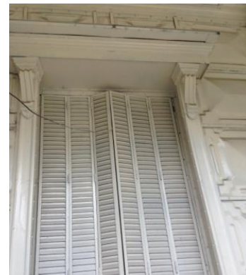
Figura 73. Persianas de metal, protegiendo puertas de madera que dan al exterior. Fuente: Elaboración propia. Año 2016.
