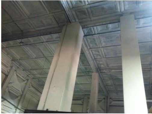
Figura 84. Sustitución de paredes metálicas por columnas de concreto para cargar el 2º nivel. Fuente: Elaboración propia. Año 2016.
