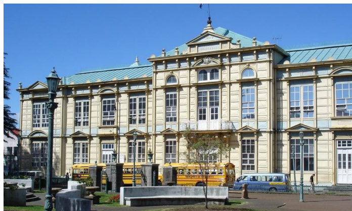
Figura 40. Edificio Metálico de Costa Rica o Escuela Buenaventura Corrales.
