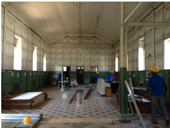
Figura 64. El Cielo Falso original de las edificaciones es de doble forro de madera machimbrada, el cual se conserva en pocas de ellas.
