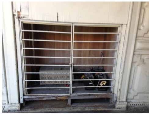
Figura 93. Sellado de hueco de puerta e instalación de baterías de respaldo del sistema de telefonía en su interior. Fuente: Elaboración propia. Año 2013.
