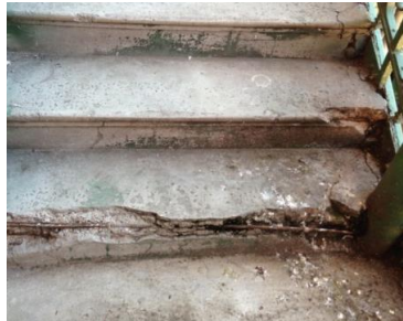
Figura 87. Colocación de concreto en peldaños de gradas metálicas. Fuente: Elaboración propia. Año 2013.
