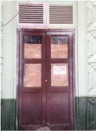
Figuras 66 y 67. Persiana de madera en la parte superior de puertas y ventanas. La ventana de madera ha sido sustituida por una de celosía de vidrio.
