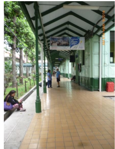
Figura 28. Pasillo de circulación. Fuente: Elaboración propia. Año 2017.
