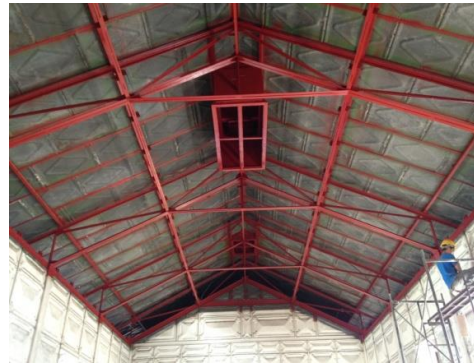
Figura 44. En su interior las láminas del techo se apoyan en estructura metálica tipo macomber espaciadas cada 3.0mts. En la foto se observa la estructura interna de la ventilación cenital. Fuente: Elaboración propia. Año 2015.
