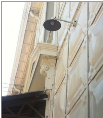
Figura 71. Frontones y canchillos de hierro adornando vanos de puertas. Fuente: Elaboración propia. Año 2015.
