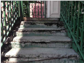
10. Colocación de concreto en huellas de gradas metálicas
