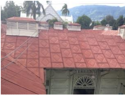
Figura 43. Techos originales de lámina troquelada con diseño y estampado especial, módulos rectangulares de 0.60m x 1.0m sujetos con pernos. Fuente: Elaboración propia. Año 2015.
