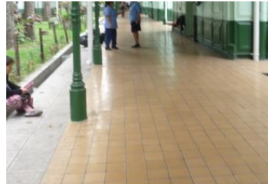
Figura 61. Piso de Pasillos de interconexión entre pabellones, actualmente sustituido.
