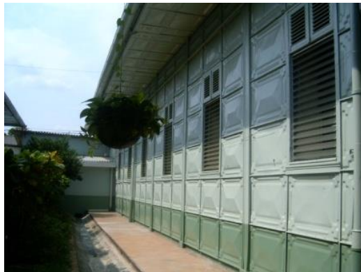
Figura 45. Paredes de lámina troquelada empernada en Pabellones de Encamados, los módulos rectangulares tienen diferentes dimensiones: 1.15m x 0.78m, 0.78m x 0.78m, 0.50m x 0.78m, 0.5m x 0.25m. Fuente: Elaboración propia. Año 2006.
