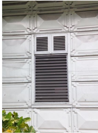
Figuras 66 y 67. Persiana de madera en la parte superior de puertas y ventanas. La ventana de madera ha sido sustituida por una de celosía de vidrio.
