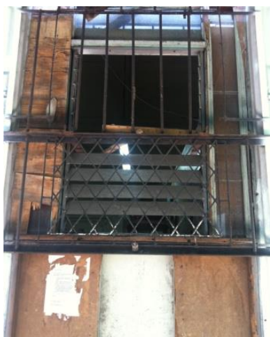
Figura 94. Cerramiento de hueco de ventana con celosía de vidrio y trozos de plywood. Fuente: Elaboración propia. Año 2013.
