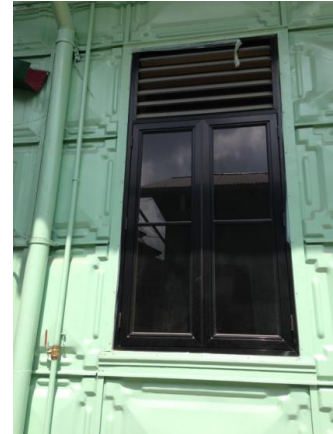
Figura 68. Persiana superior y ventana de aluminio anodizado. Instaladas en 6 pabellones (2015).
