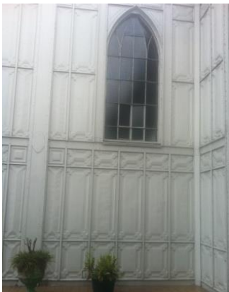
Figuras 46, 47 y 48. Paneles metálicos con diferentes dimensiones y estampado especial, en paredes de Capilla, exterior de edificio de Pensionados e interior de Edificio Administrativo, respectivamente. Fuente: Elaboración propia. Año 2015.
