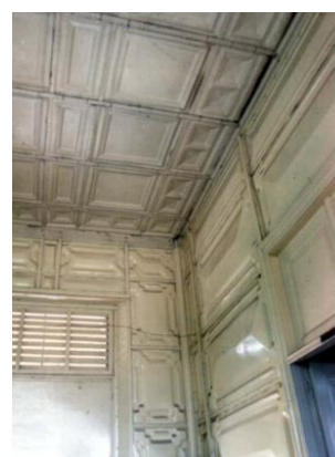
Figuras 46, 47 y 48. Paneles metálicos con diferentes dimensiones y estampado especial, en paredes de Capilla, exterior de edificio de Pensionados e interior de Edificio Administrativo, respectivamente. Fuente: Elaboración propia. Año 2015.
