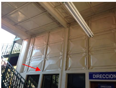
Pared Sur: media altura de sistema mixto y el resto de lámina troquelada
