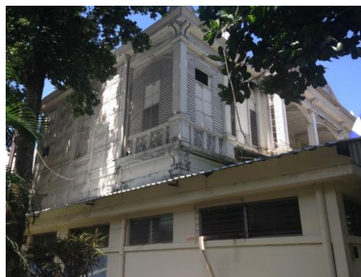
Figura 97. Construcción de anexos de sistema mixto (ladrillo de barro y concreto) a los lados de los edificios metálicos. Fuente: Elaboración propia. Año 2013.
