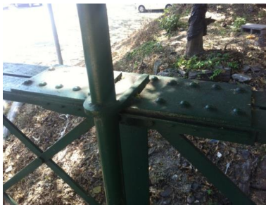
Figura 54. Uniones emperradas en el puente. Al igual que en todas las edificaciones no hay ningún elemento soldado. Fuente: Elaboración Propia. Año 2013.
