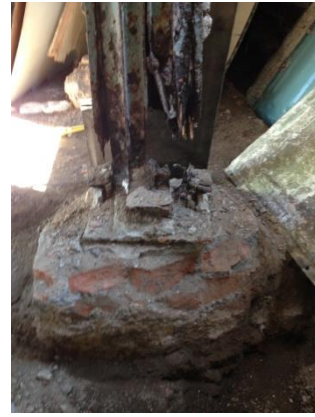
Figuras 52 y 53. Los cimientos de los edificios son de mampostería en unos casos de piedra y en otros de ladrillo de barro, en las cuales se encuentran empotradas o apoyadas las columnas de metal. Elaboración propia. Año 2015.
