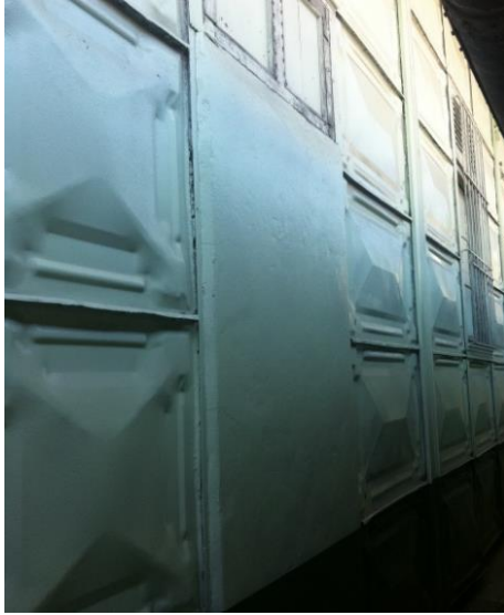
Figura 98. Sellado de hueco de puerta con pared de ladrillo de barro, afinado, repellado y pintado. Fuente: Elaboración propia. Año 2013.
