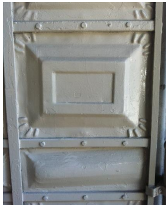
Figuras 46, 47 y 48. Paneles metálicos con diferentes dimensiones y estampado especial, en paredes de Capilla, exterior de edificio de Pensionados e interior de Edificio Administrativo, respectivamente. Fuente: Elaboración propia. Año 2015.
