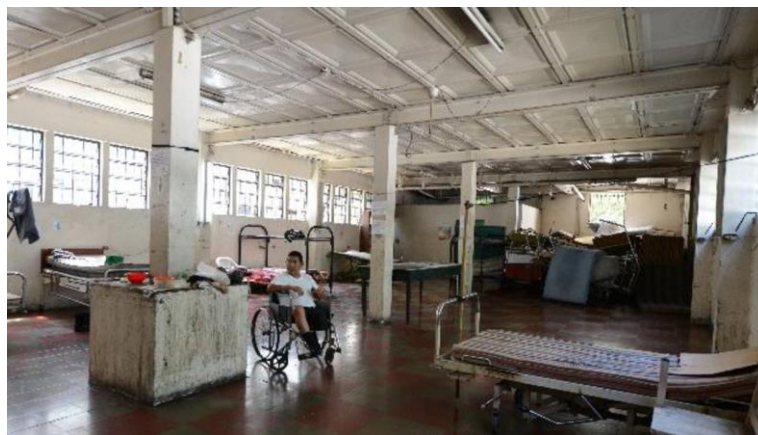
Figura 75. Pabellón de Cirugía Hombres, en la planta baja han sido retiradas las paredes de carga y se han sustituido por columnas de concreto.
