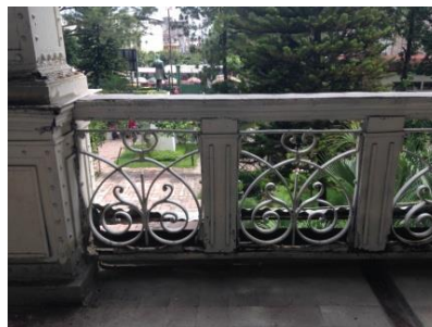
Figura 72. Barandal metálico en terraza de Edificio Administrativo. Fuente: Elaboración propia. Año 2016.
