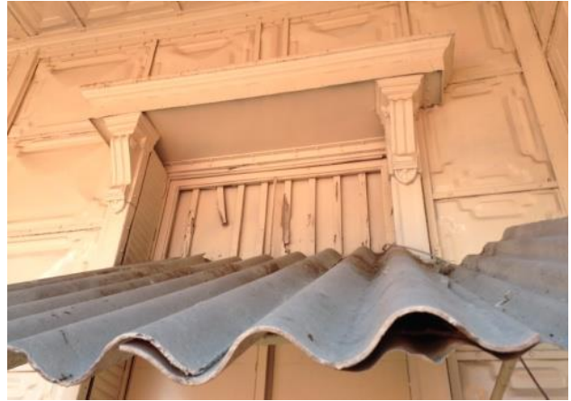
Figura 99. Instalación de aleros de fibrocemento a media altura de puertas. Fuente: Elaboración propia. Año 2013.
