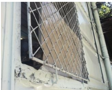
Figura 86. Instalación de defensas metálicas con marco de concreto en hueco de ventana. Fuente: Elaboración propia. Año 2013.
