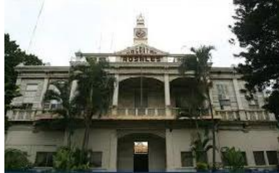
Figura 85. Edificio Administrativo, los arcos del primer nivel han sido sellados con paredes. Fuente: Elaboración propia. Año 2016.
