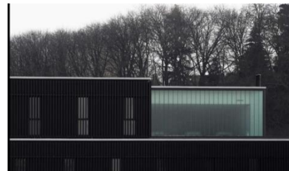
Imagen 38: Centro de Acogida en Pamplona-Fachada sur
