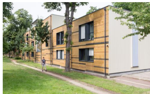
Imagen 21: Centro de hospedaje de emergencia "Promesa de amor"-Vista Sur este
