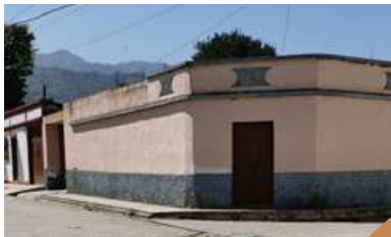
Imagen no. 64: Tipología constructiva del área periurbana Fuente: Lindsey Folgar Morán, Febrero 2021
