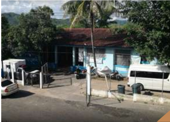
Imagen no. 81: Centro de Salud de Sansare Fuente: Google Maps. Marzo 2021
