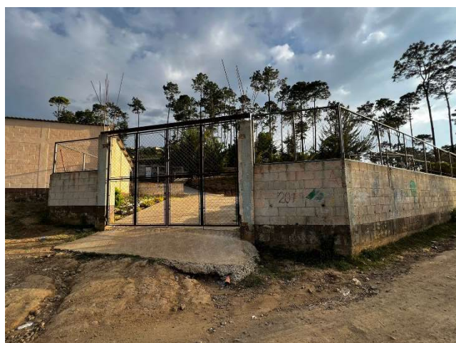
Figura 110. Escuela primaria Fuente: elaboración propia
