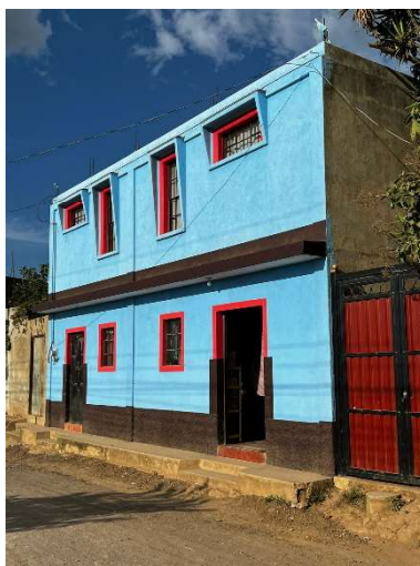
Figura 94. Construcción de block dos niveles Fuente: elaboración propia
