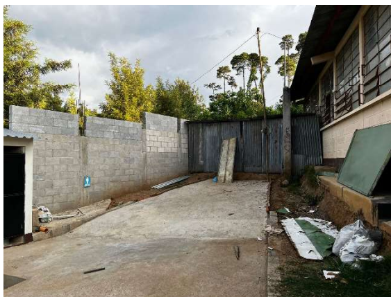
Figura 134. Bodega de mantenimiento Fuente: elaboración propia
