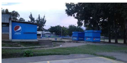
Figura 54. Instituto Enrique Gómez Carrillo Fuente: Fotografía por Google Maps
