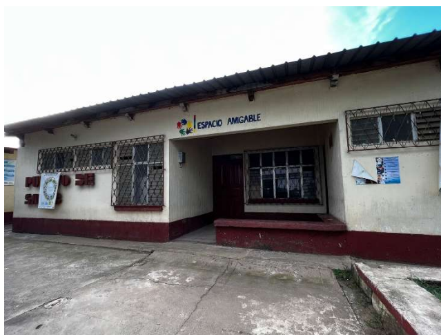
Figura 104. Centro de salud Fuente: elaboración propia
