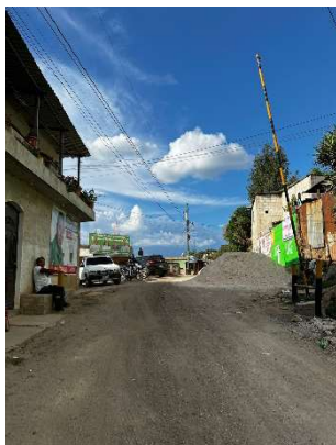
Figura 86. Calles de terracería en buen estado Fuente: elaboración propia
