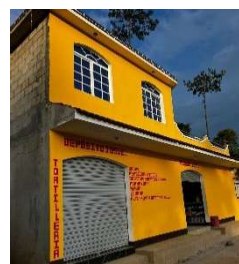
Figura 118. Viviendas Fuente: elaboración propia
