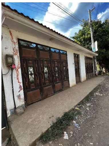
Figura 93. Construcción de block un nivel Fuente: elaboración propia
