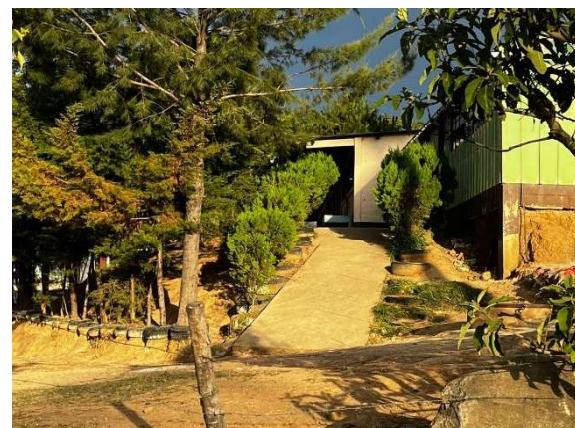
Figura 124. Salida de módulo de aulas 2 Fuente: elaboración propia
