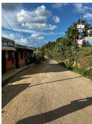
Figura 88. Calles de terracería en buen estado Fuente: elaboración propia
