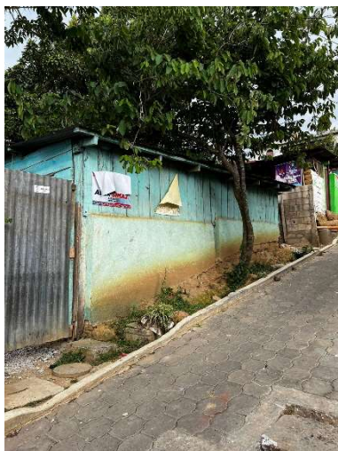
Figura 97. Construcción de madera Fuente: elaboración propia
