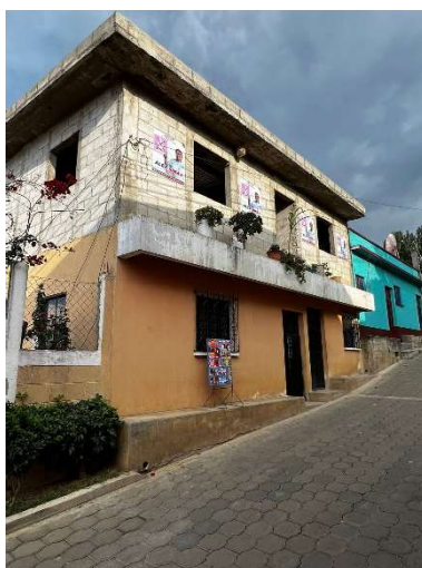
Figura 96. Construcción de block dos niveles Fuente: elaboración propia
