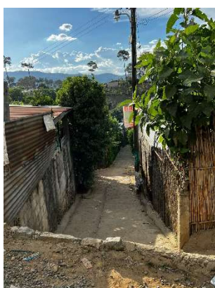
Figura 90. Calles de terracería en buen estado Fuente: elaboración propia
