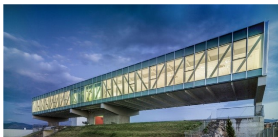
Figura 61. Viga Vierendeel
