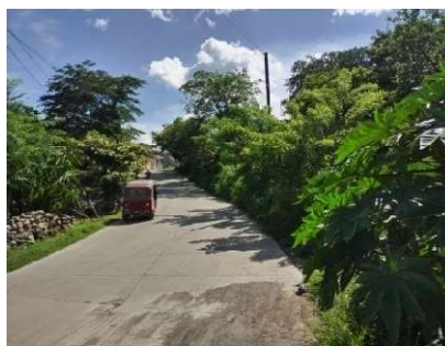
Figura 56. Carretera ingreso a terminal de buses Fuente: elaboración propia
