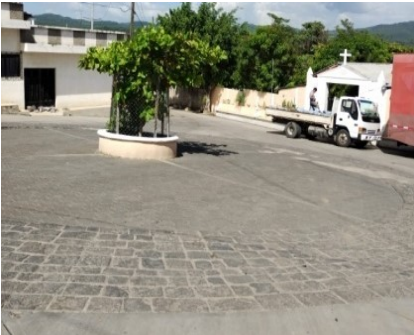
Figura 46. Ingreso 3a calle Fuente: elaboración propia
