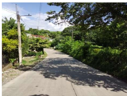
Figura 55. Carretera ingreso a terminal de buses Fuente: elaboración propia
