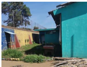
Figura 78, Fotografía 06 – Infraestructura sin uso y terreno con lindante con muro de contención Terreno. (2021) Elaboración propia
