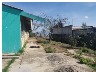
Figura 77, Fotografía 05 – Infraestructura sin uso y vivienda colindante. (2021) Elaboración propia
