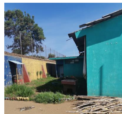
Figura 62, Muro de contención y construcción existente sin uso. (2021) Elaboración propia
