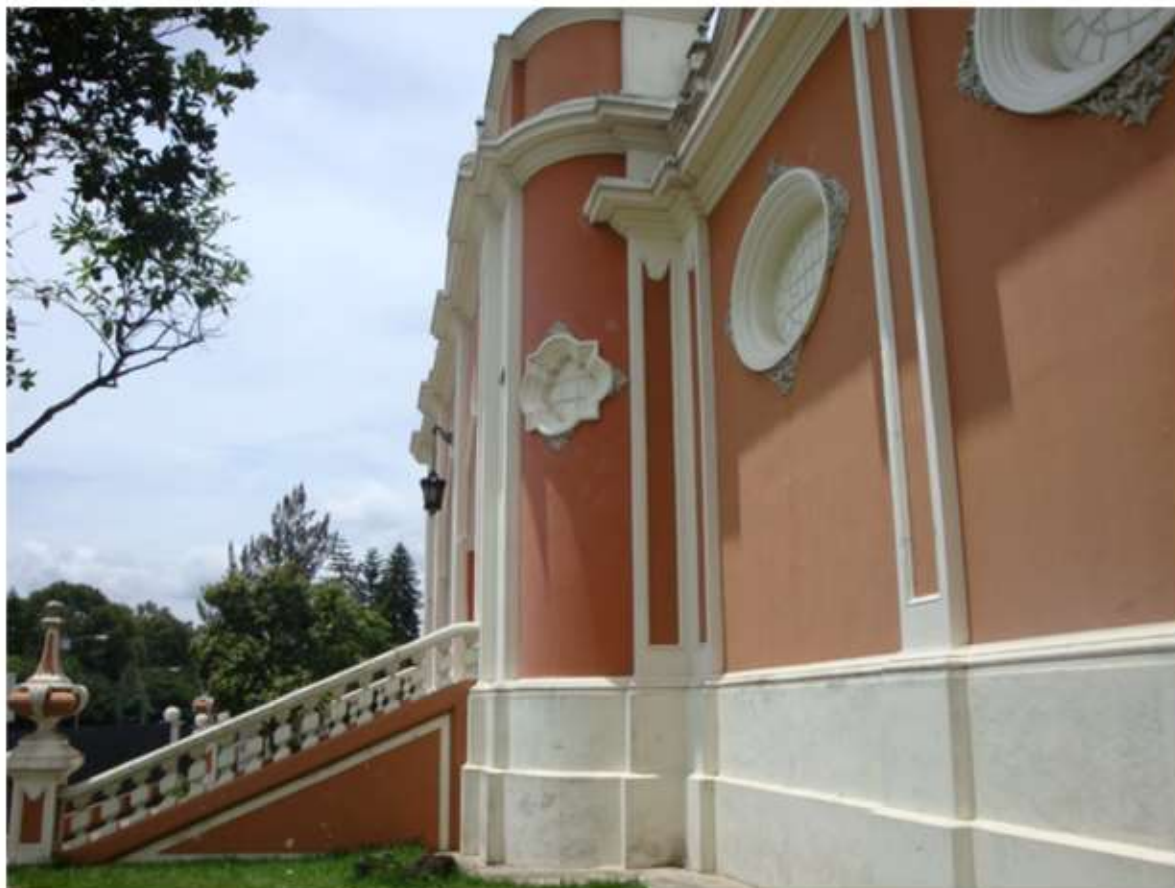
Figura 65 Vista lateral de pórtico
