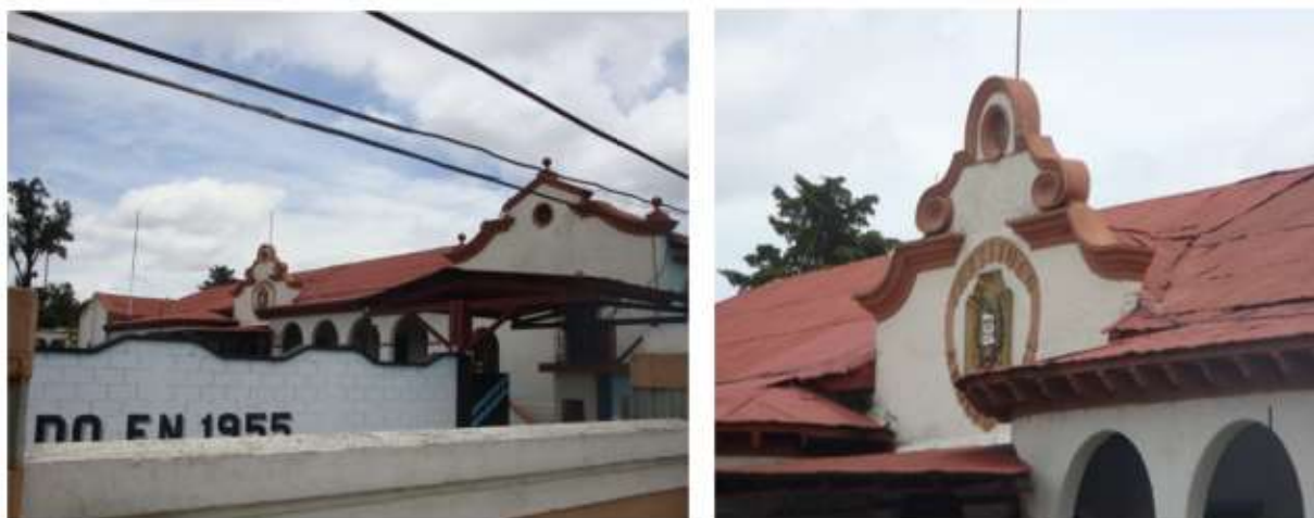
Figura 12 Segundo edificio de la Policía Nacional
