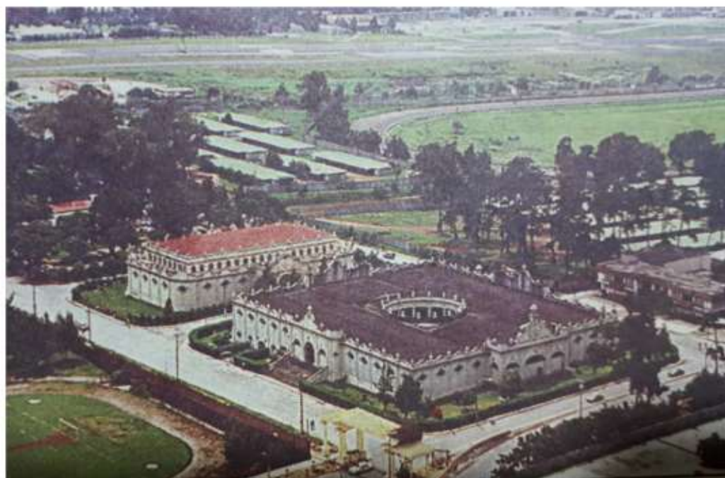
Figura 26 Vista panorámica Salón 5
