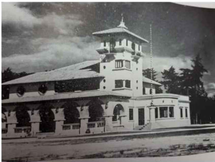
Figura 22 Edificio aeropuerto La Aurora, 1936
