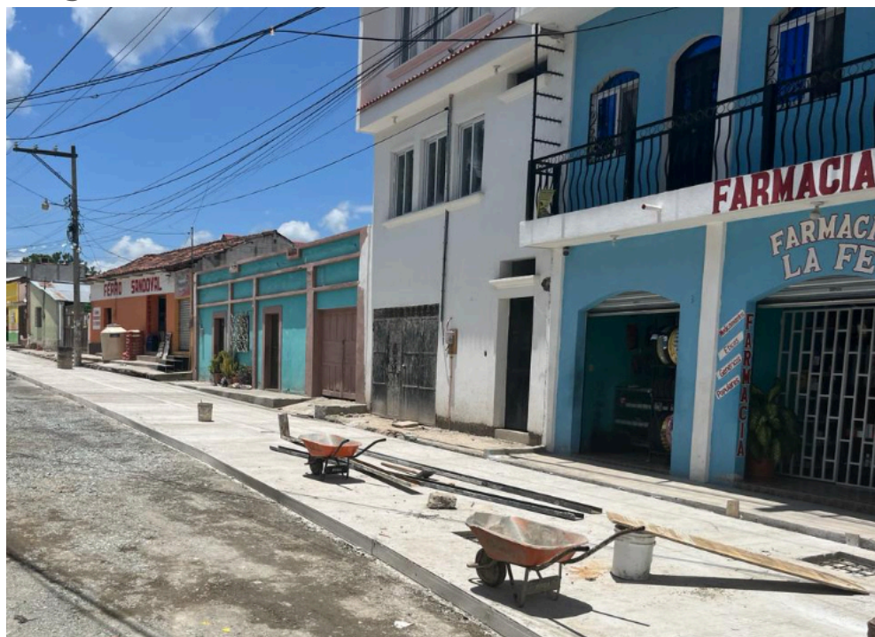
Ilustración 66. Imagen de calle posterior a la municipalidad Fuente: Elaboración propia
