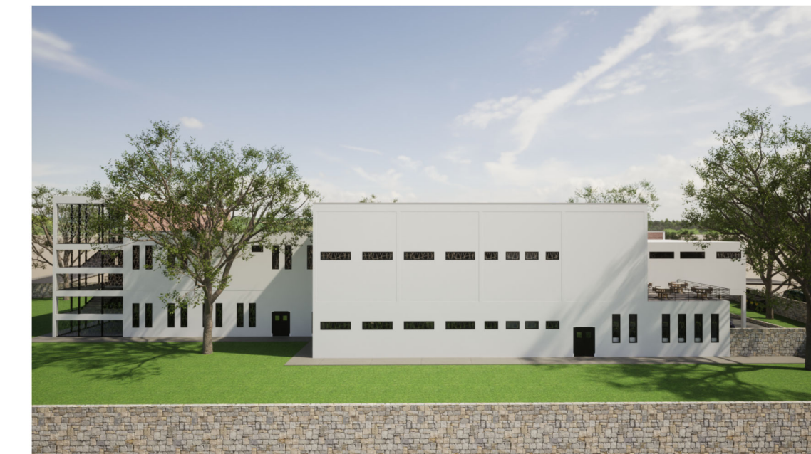
4. VISTA FACHADA POSTERIOR
