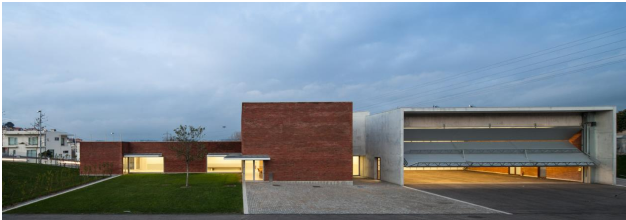
Figura 25 Estación de Bomberos de Santo Tirso, Portugal. Fuente: https://www.plataformaarquitectura.cl/cl/02-239308/estacion-de-bomberos-de-santo-tirso-alvaro-siza/512216dfb3fc4bfa27000260-fire-station-in-santo-tirso-alvaro-siza-photo?next_project=yes
