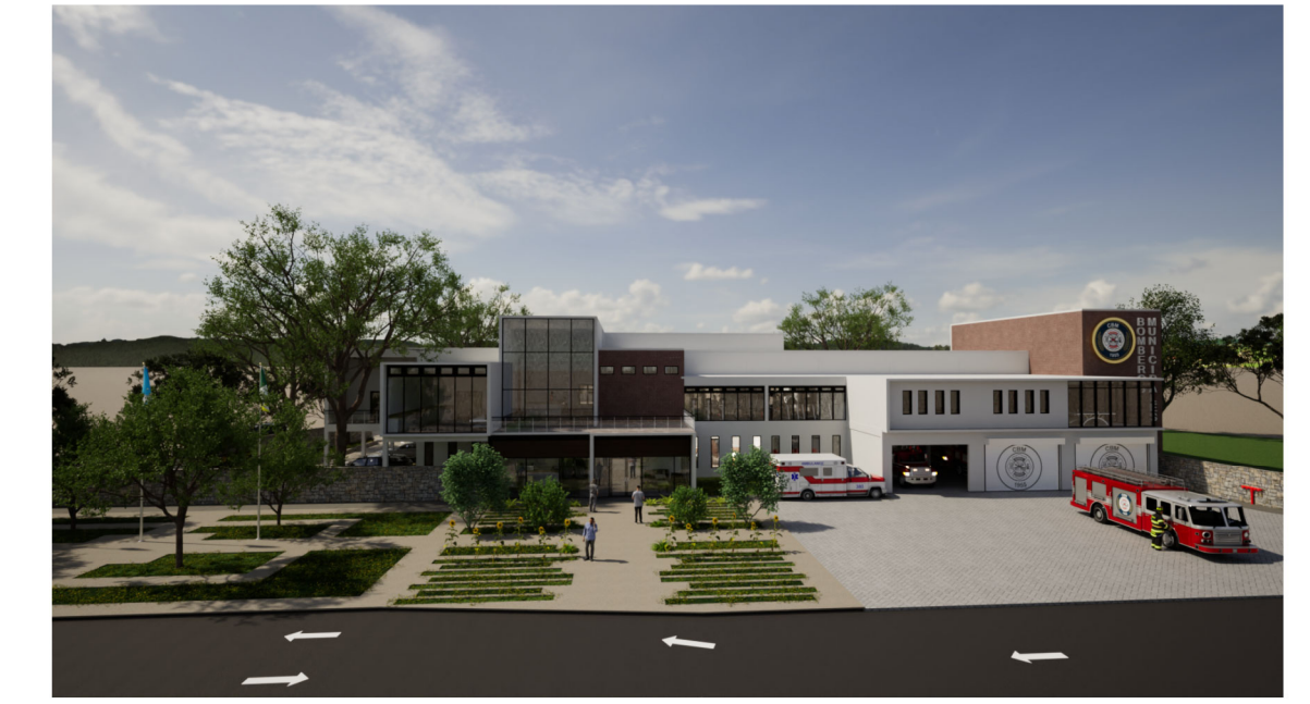
3. VISTA DE FACHADA FRONTAL
