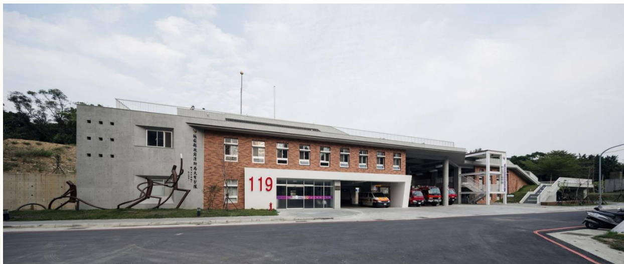
Figura 43 Exterior Estación de Bomberos Da-Yo. Fuente: https://www.plataformaarquitectura.cl/cl/02-338640/estacion-de-bomberos-da-yo-k-architect/52fff263e8e44e54820001c8-da-yo-fire-station-k-architect-photo
