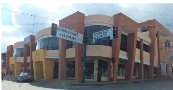
Imagen 47 , Centro comercial. Elaboración propia. 2023
