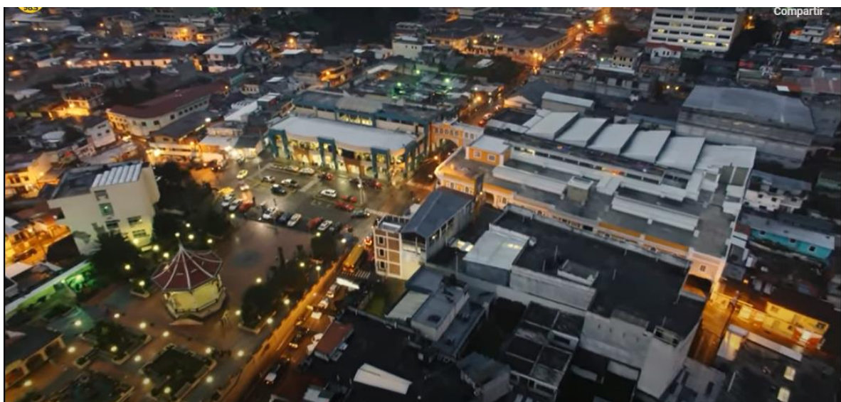
Imagen 30. Vista nocturna de la Ciudad de San Marcos. Fuente: aprendeguatemala.com
