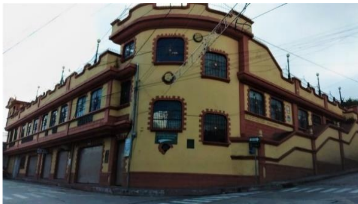
Imagen 52, Esquina de la 7ª. “A” Avenida y 9ª. Calle zona 1, Municipalidad de San Marcos. Elaboración propia. 2023.
