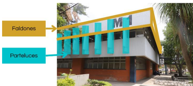
Figura 67. Análisis de edificio M-1, Campus Central USAC.
