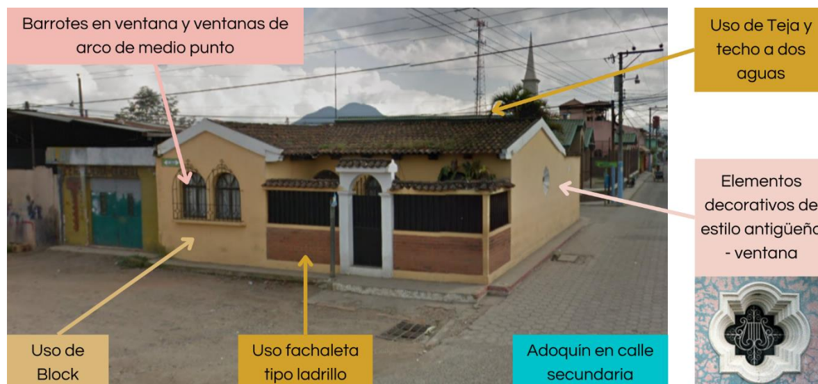
Figura 134. Análisis tipológico constructivo de vivienda CA-1, El Tejar, Chimaltenango. Elaboración propia con base a Google Maps..
