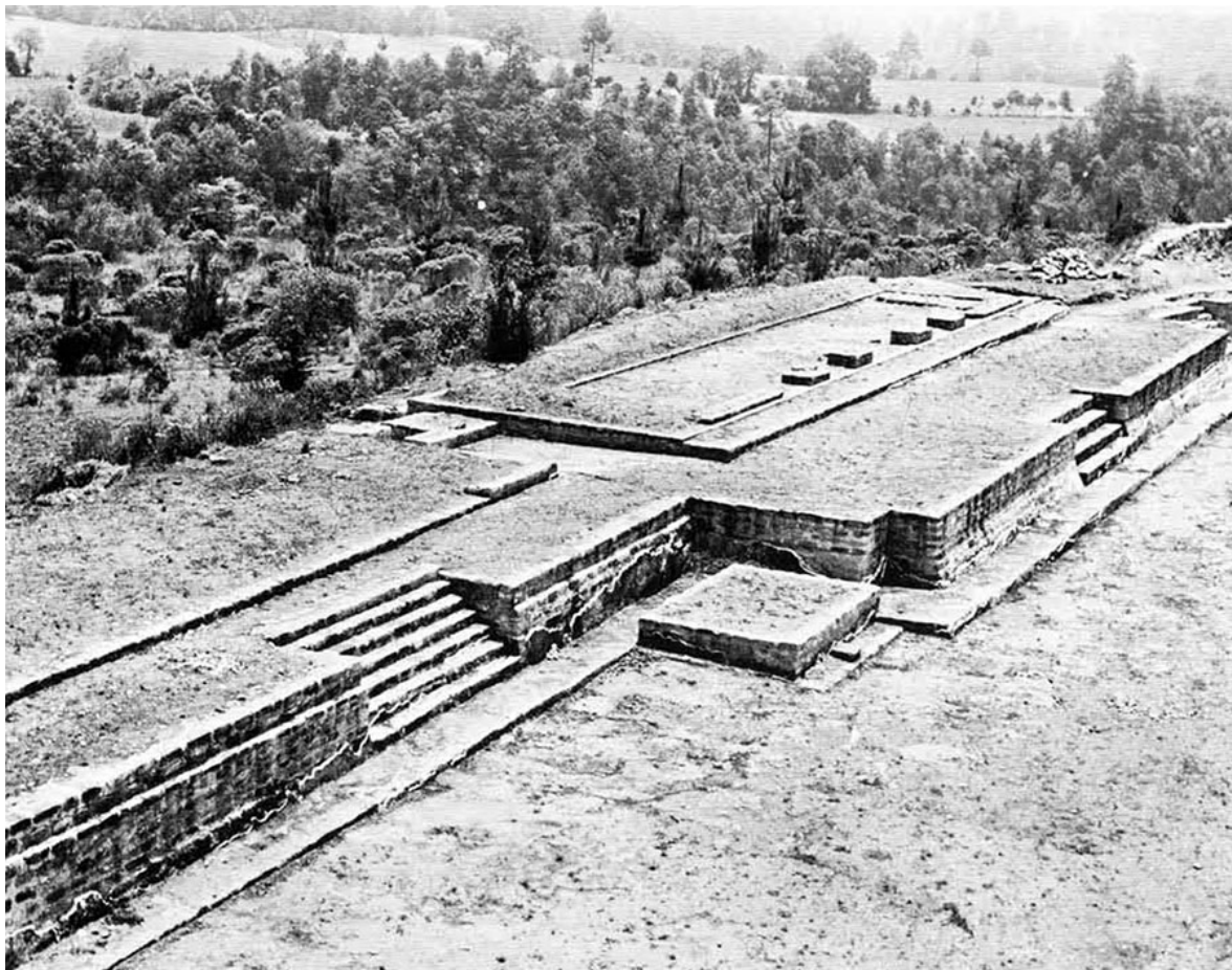
Figura 27. Estructura 23 en primer plano, con 22 más allá, ambos palacios en el lado norte de la Plaza A.
