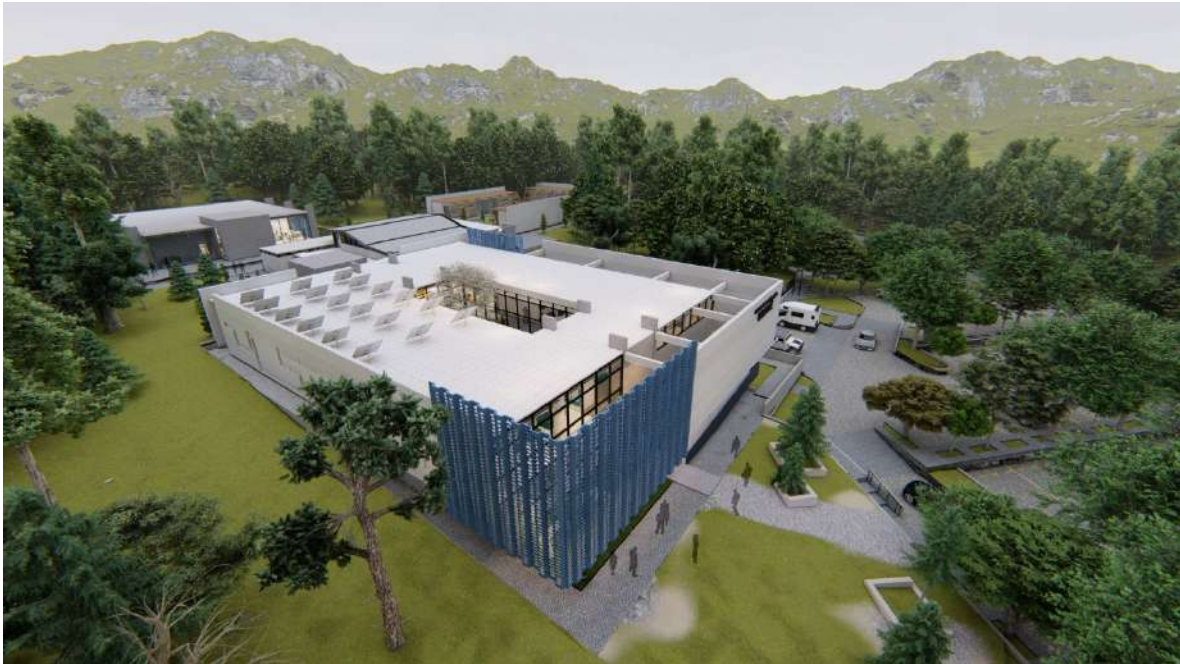
VISTA FRONTAL DE CONJUNTO
