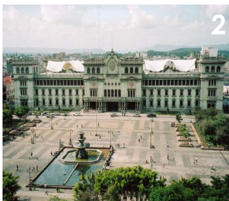
FOTOGRAFÍA 91. Plaza de la Constitución FUENTE: https://www.guatevalley.com/que-visitar/plaza-de-la-constitucion-guatemala
