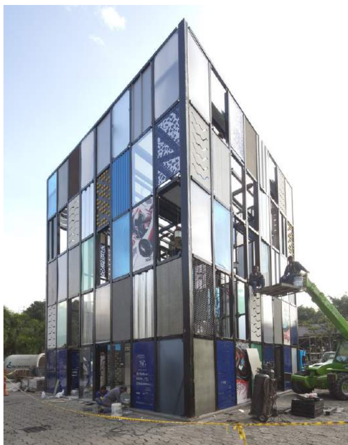
FOTOGRAFÍA 108 Pabellón Social Abierto
