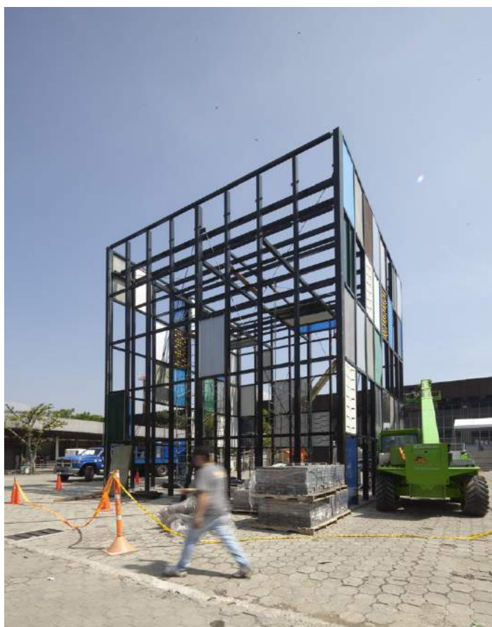
FOTOGRAFÍA 107 Pabellón Social Abierto
