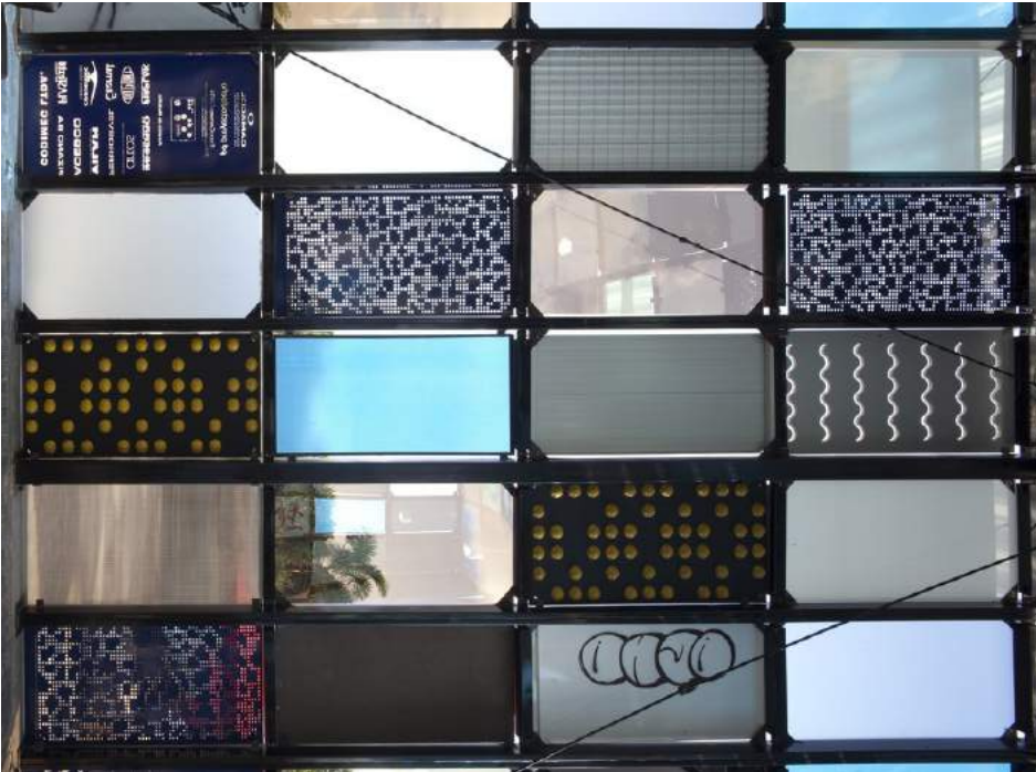
FOTOGRAFÍA 110 Pabellón Social Abierto
