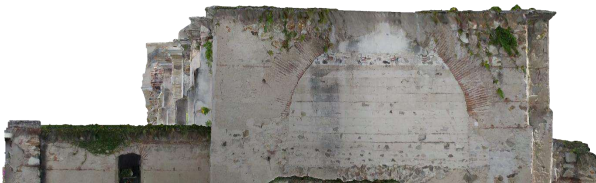
Ilustración 55. Muro testero del templo.
