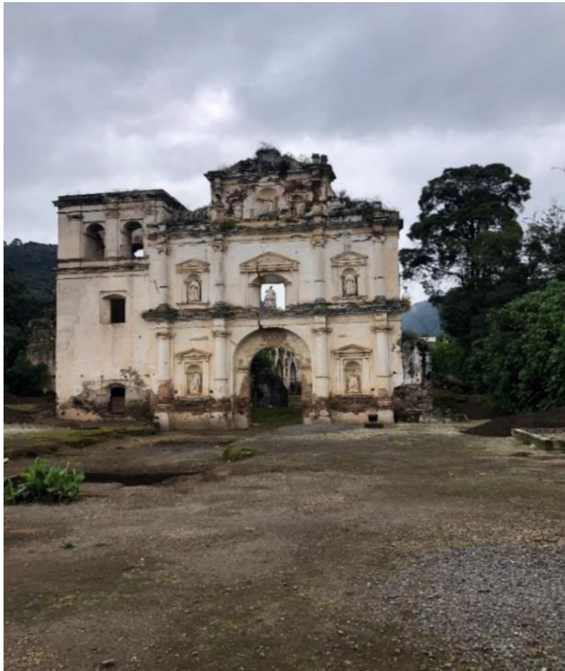
Ilustración 22. Inspección del área por levantar.
