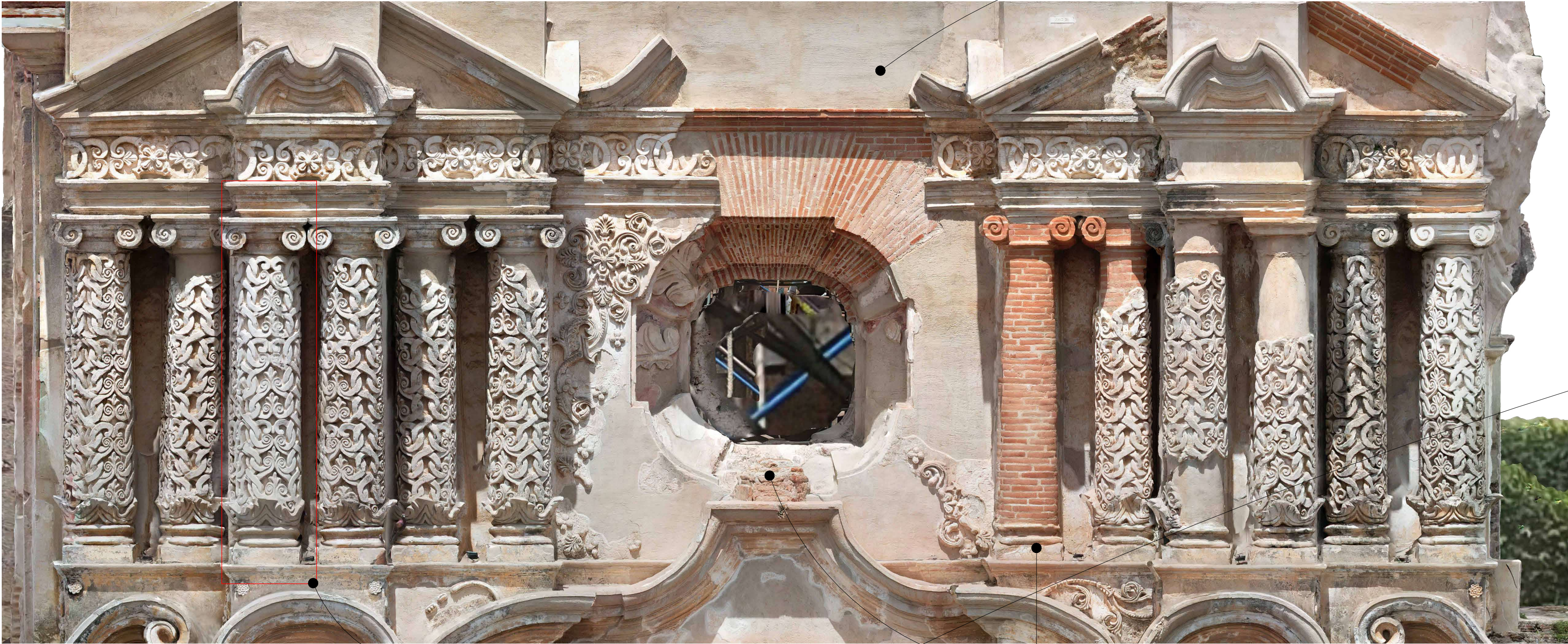
RECONSTRUCCIÓN DE LA COLUMNA EN LA PRIMERA INTERVENCIÓN
