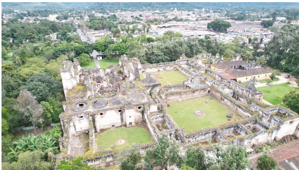
Ilustración 25. Fotografía aérea del Templo de la Recolección. FUENTE: MARCELO ASTURIAS, 2023
