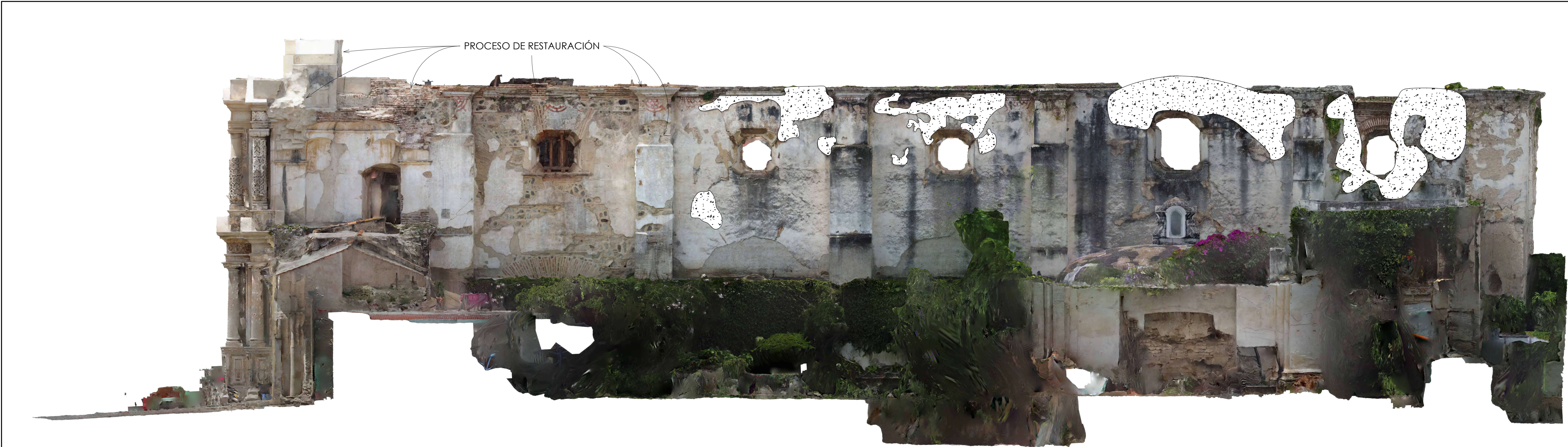
DESPRENDIMIENTO DE MATERIAL 1 : 75
