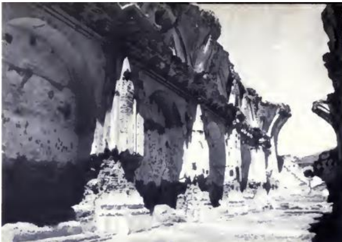
Ilustración 7. Interior del Templo FUENTE: VERLE ANNIS, 1968.
