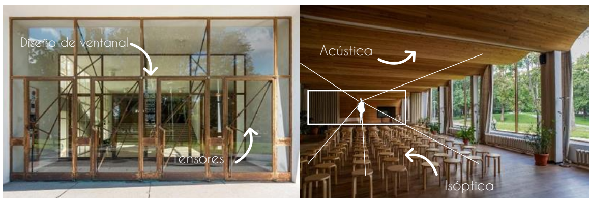
Figura 35, 36: Detalle del ingreso y techo del auditorio.
