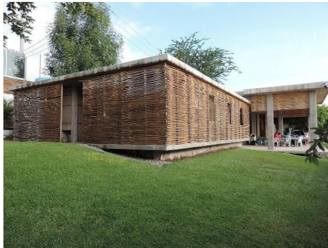
Imagen 9: Edificio comunitario de muros de bahareque y celosía de carrizo. Vista Posterior.
