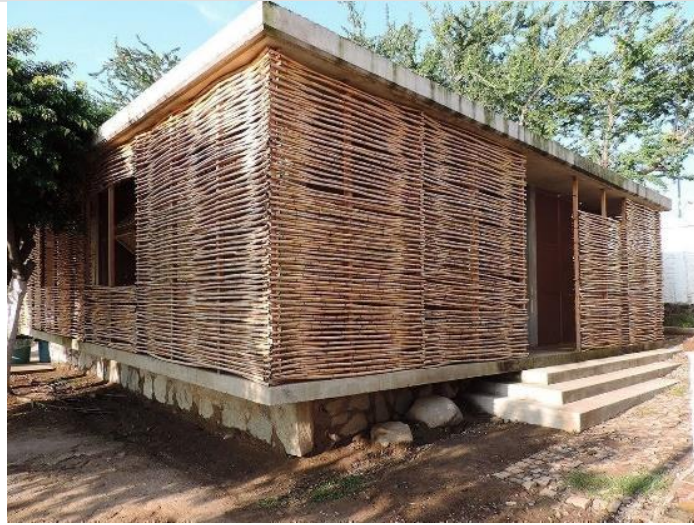
Imagen 8: Edificio comunitario de muros de bahareque y celosía de carrizo. Vista lateral.
