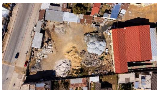
Figura 102: Vista aérea del terreno.
