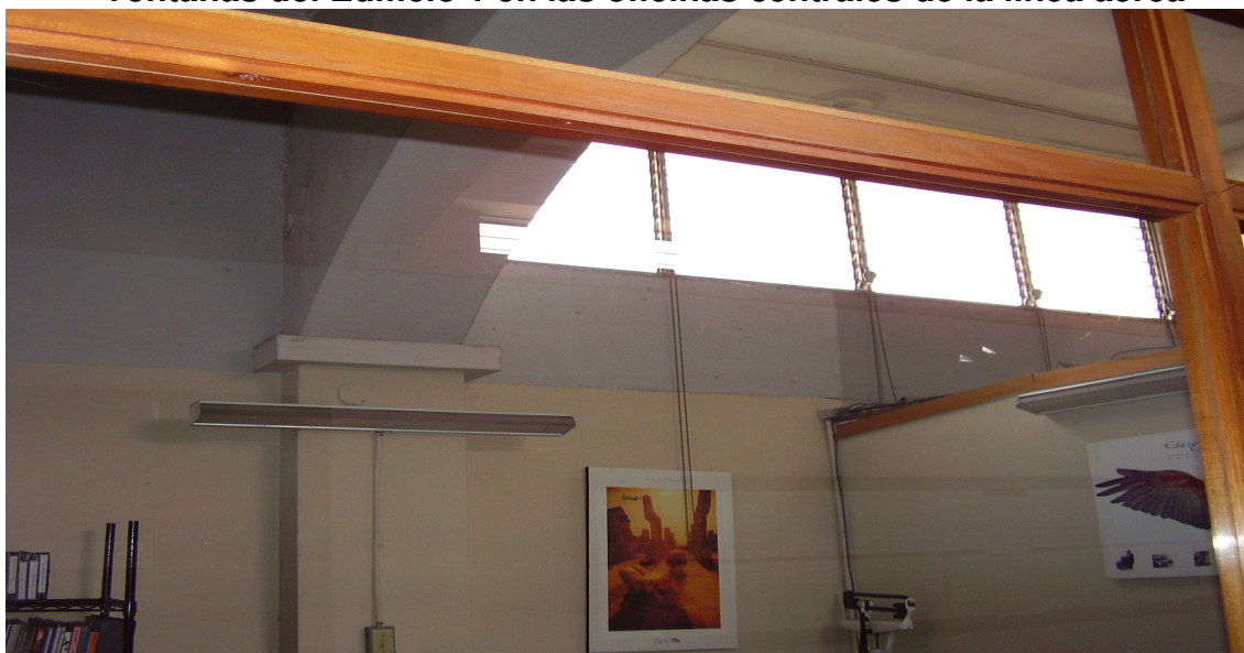
Ilustración No. 8 Ventanas del Edificio 1 en las oficinas centrales de la línea aérea
