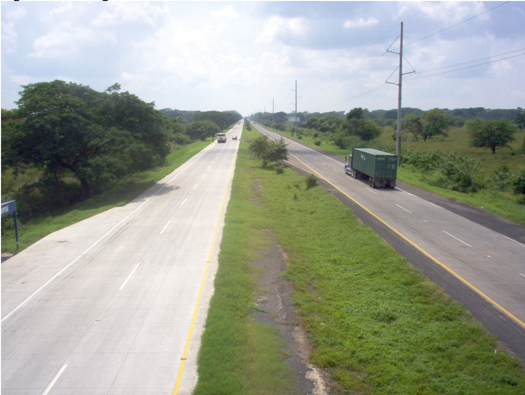
Figura 3.9 Fotografía del tramo CA-09 Sur.
