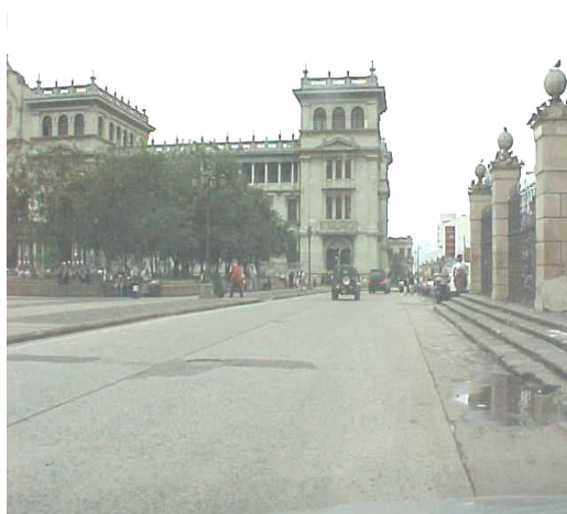
Figura 1.1 Fotografía de pavimentos de concreto zona 1. Guatemala.
