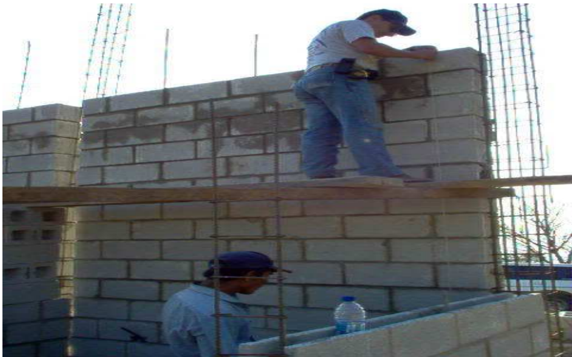
Levantado de paredes
