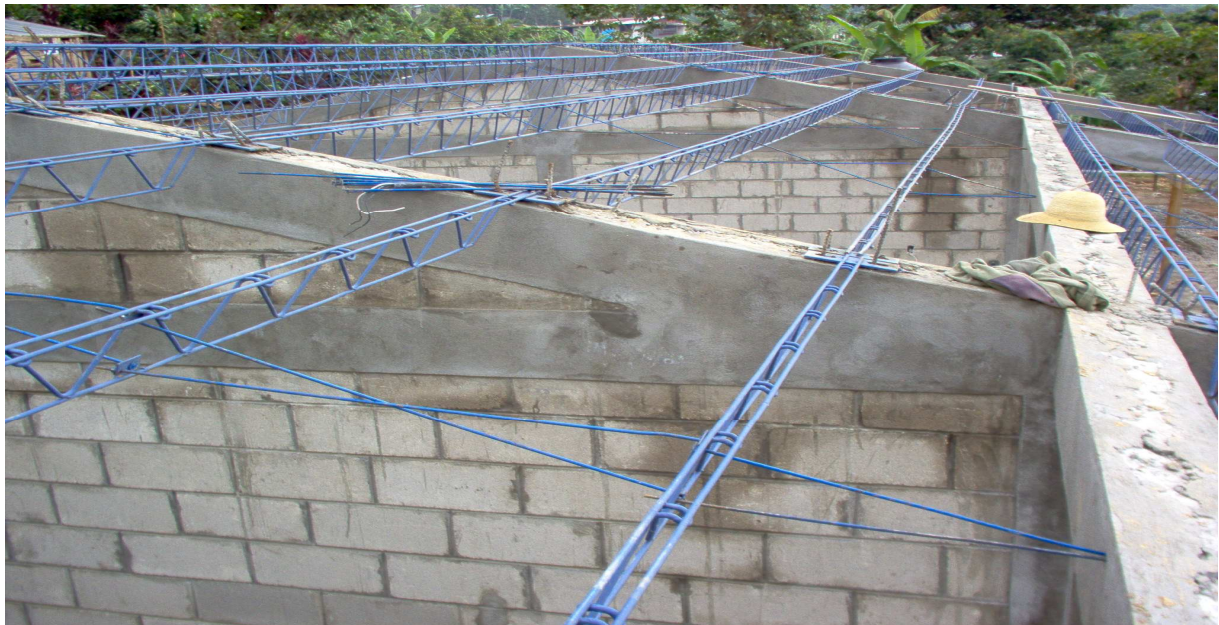
Estructura y cubierta
